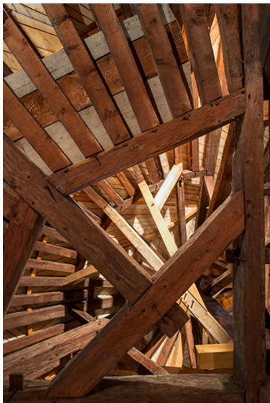
Enrayure nord-est de la charpente du dôme.
