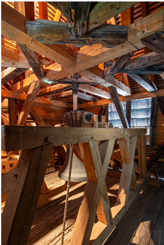
Campanile de la sacristie. Charpente du beffroi.
