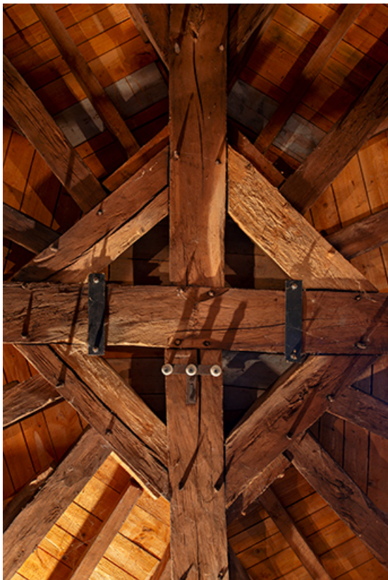
Charpente du dôme. Enrayure centrale.
