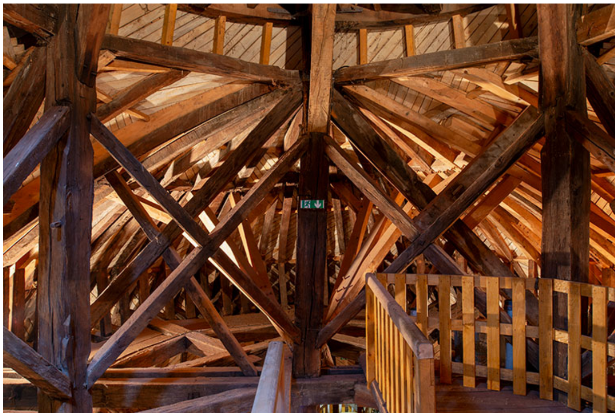
Partie orientale de la charpente, depuis le niveau intermédiaire. Vue axiale. 39, Salins-les-Bains place des Alliés
