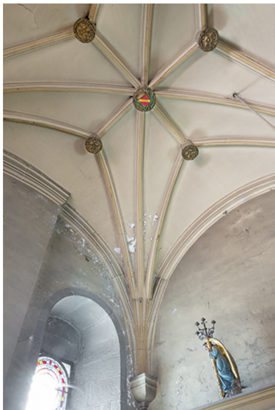
Voûtement de la chapelle axiale depuis le nord-est. 39, Salins-les-Bains place des Alliés
