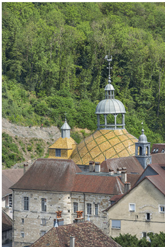
Vue plongeante depuis le sud-est.
