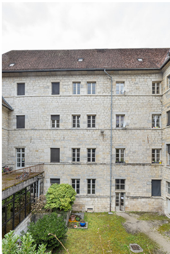
Façade sur cour de l'aile ouest.
