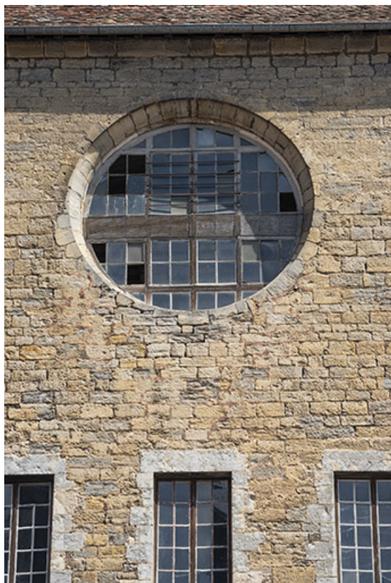
Partie supérieure de la façade ouest de la chapelle.
