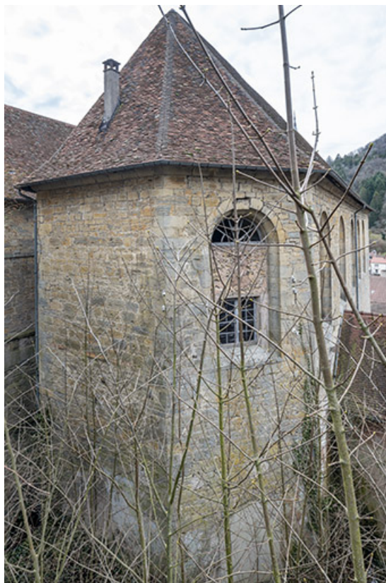
Chevet de la chapelle, depuis le nord.
