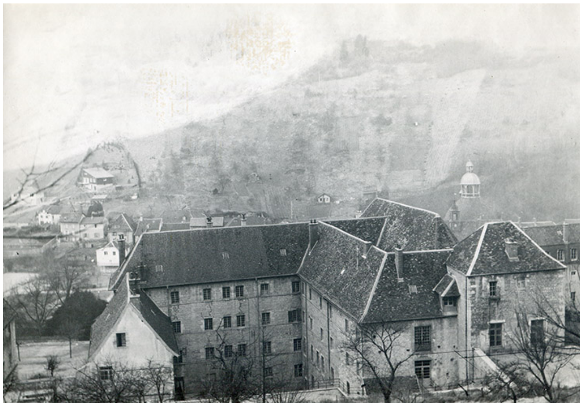
Vue plongeante depuis l'est, s.d. [milieu 20e siècle].
