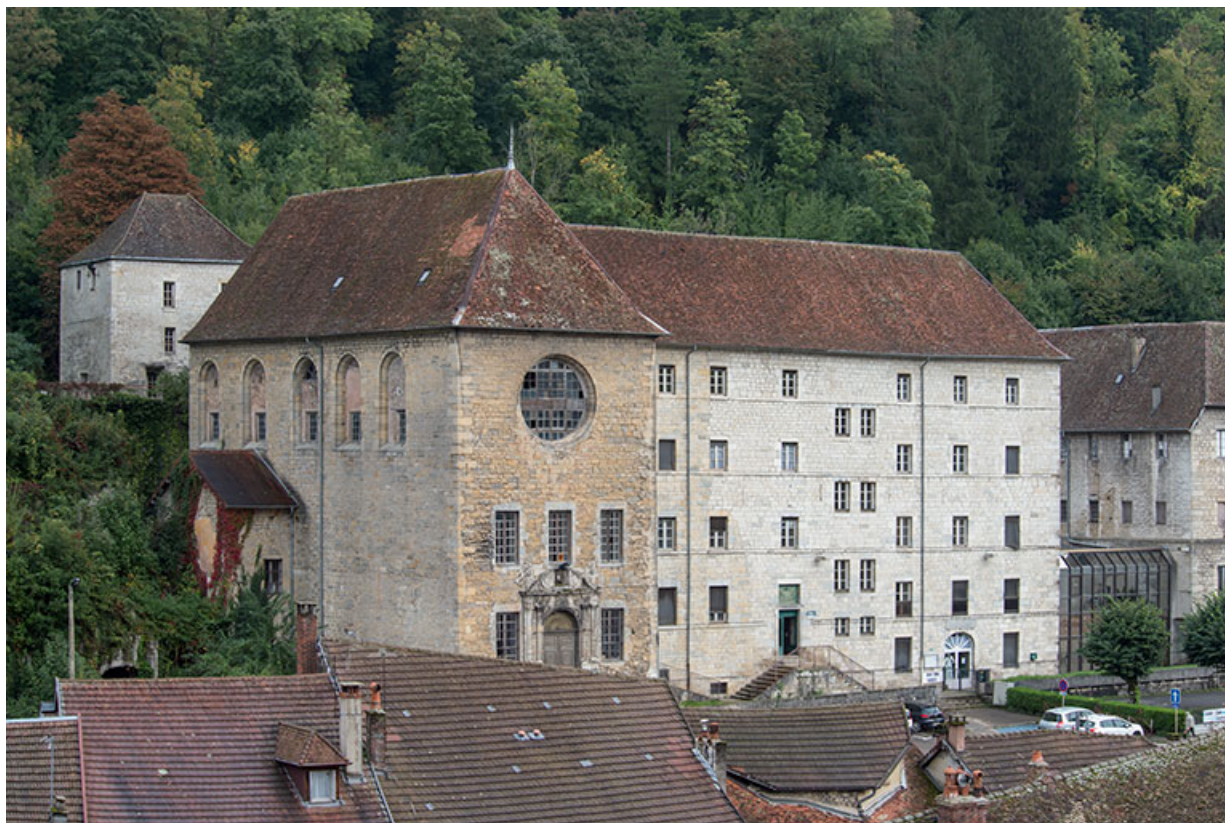
Vue rapprochée depuis le nord-ouest.
