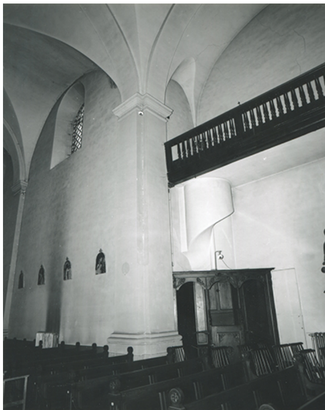
Mur est de l'église et tribune du transept, 1997.
