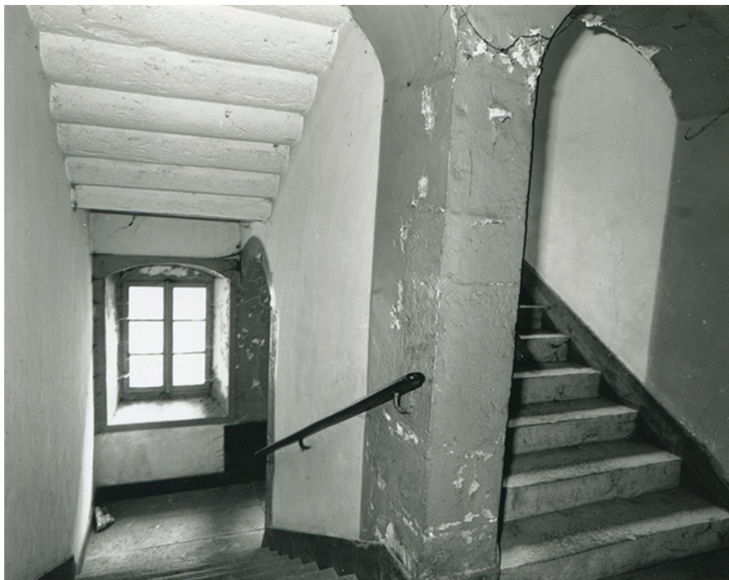
Bâtiment conventuel. Escalier du 17e siècle, 1997.
