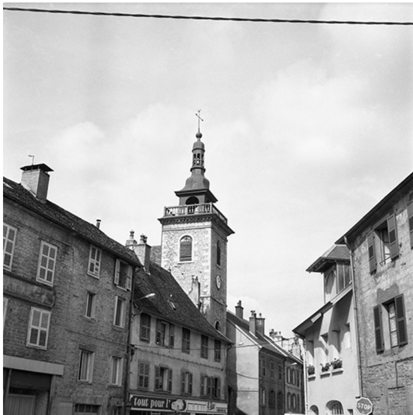
Façades de l'ancien couvent et clocher de l'église, s.d. [vers 1970].
