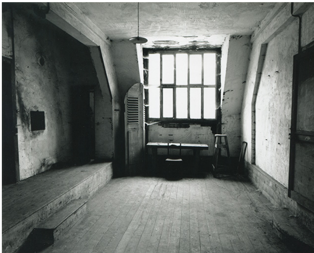
Etage de comble du bâtiment conventuel. Atelier, 1997.
