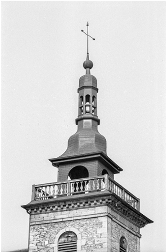
Le clocher à bulbe de l'église Saint-Jean-Baptiste, s.d. [vers 1970]. 39, Salins-les-Bains, 68-76 rue Louis Pasteur
