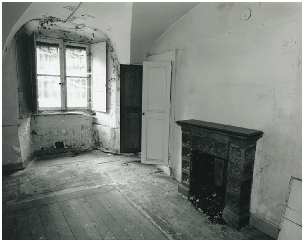
Rez-de-chaussée du bâtiment conventuel. Pièce voisine à l'angle sud-ouest, 1997.
