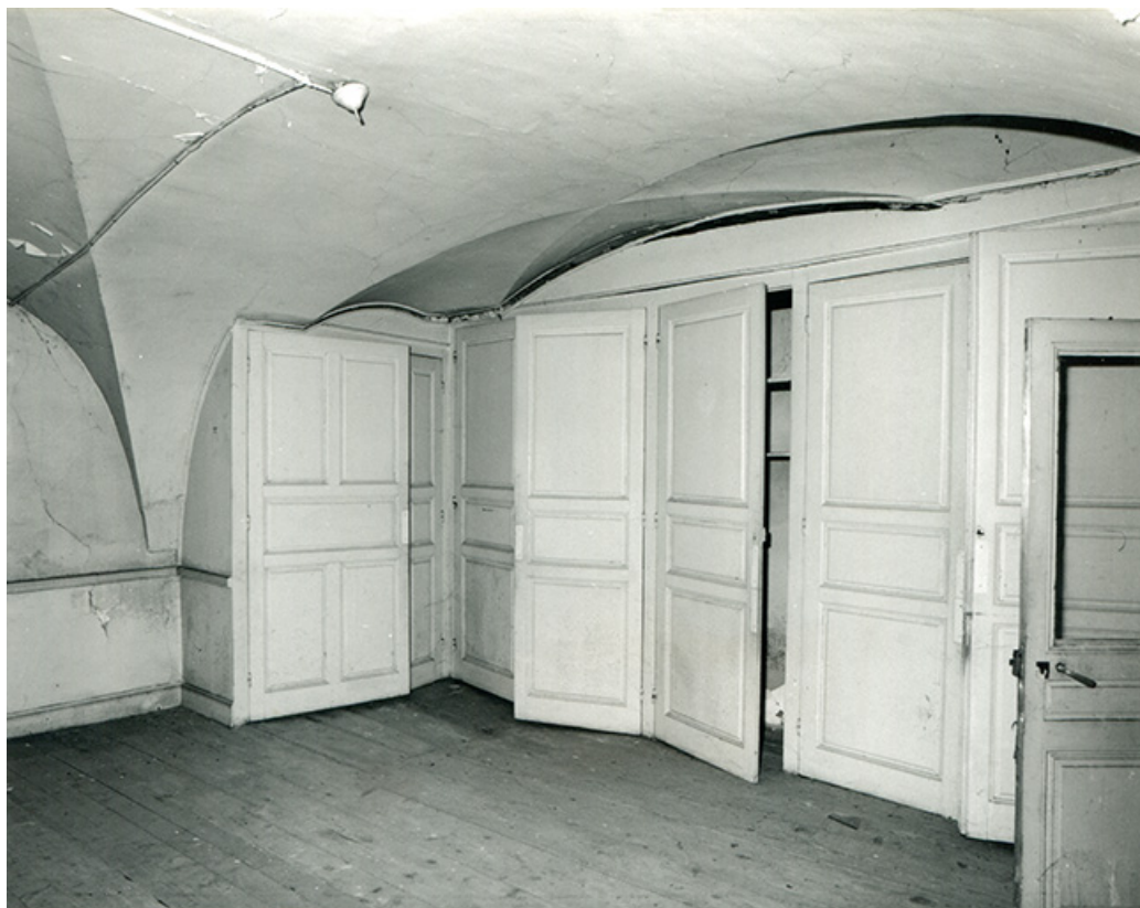
Rez-de-chaussée du bâtiment conventuel. Pièce côté sud, 1997.
