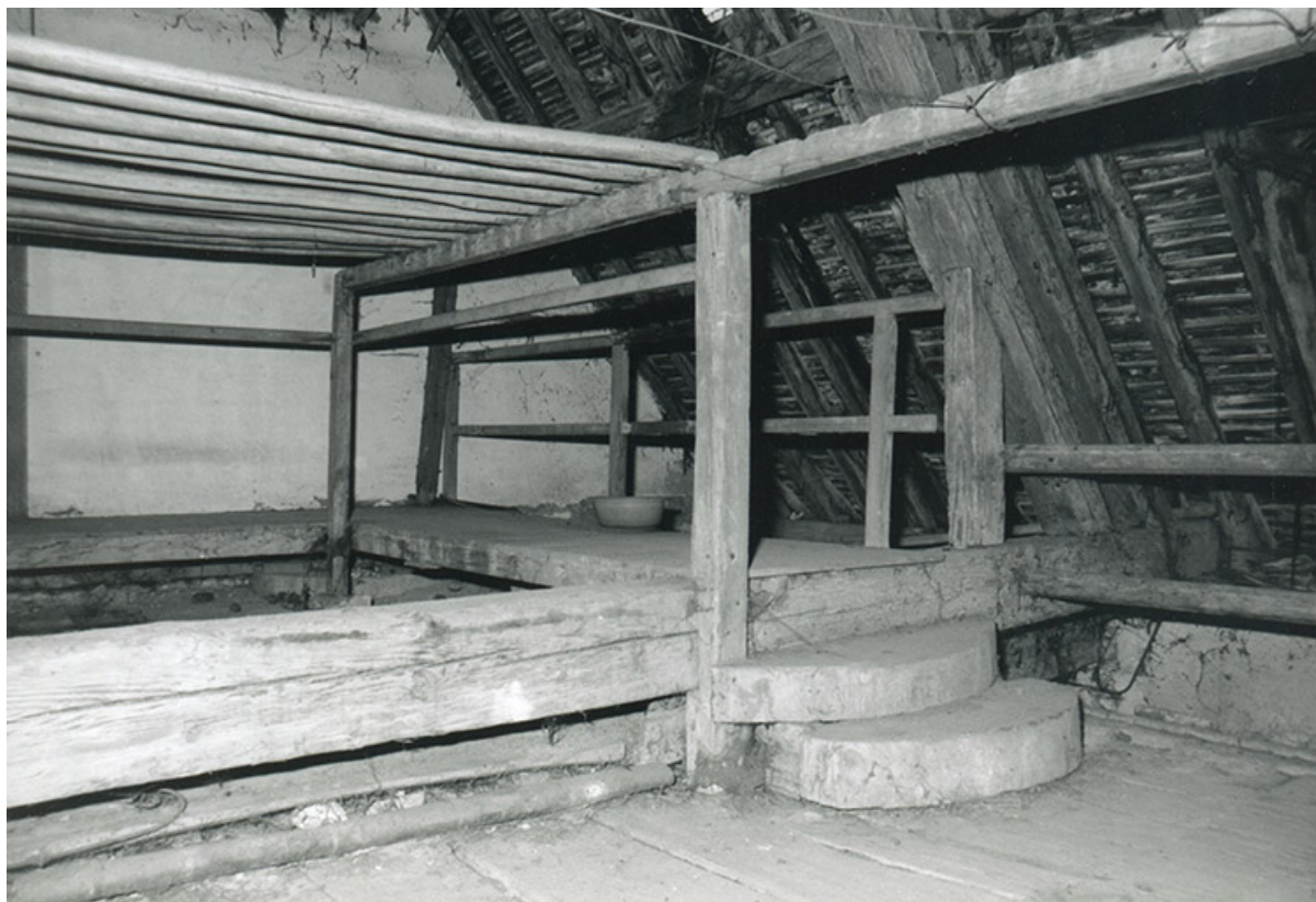
Etage de comble du bâtiment conventuel. Etendoirs (?), 1997.
