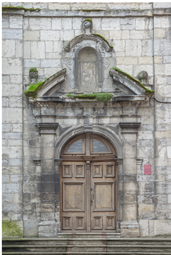
Façade nord. Porte centrale.
