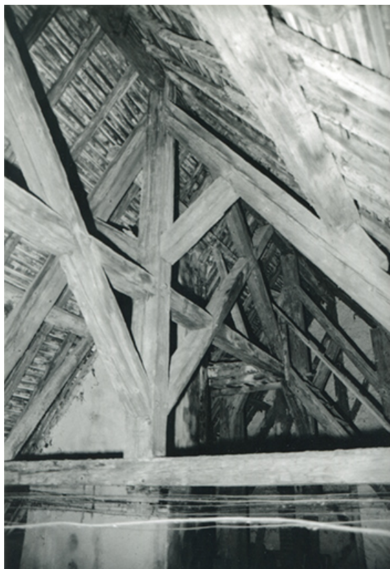
Charpente du bâtiment conventuel, 1997.
