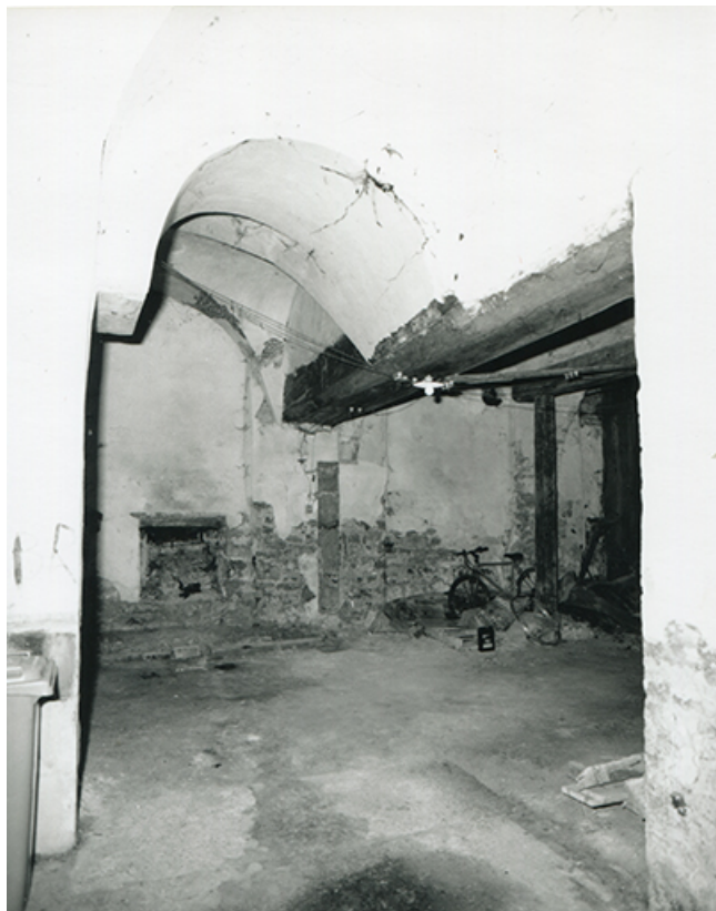
Rez-de-chaussée du bâtiment conventuel, 1997.
