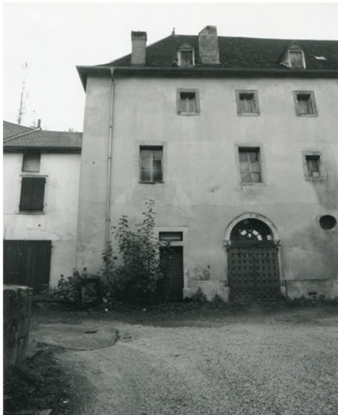
Façade nord du bâtiment conventuel. Travées orientales, 1997. 39, Salins-les-Bains, 68-76 rue Louis Pasteur
