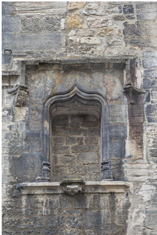
Mur-pignon ouest. Niche située en partie basse, à droite.
