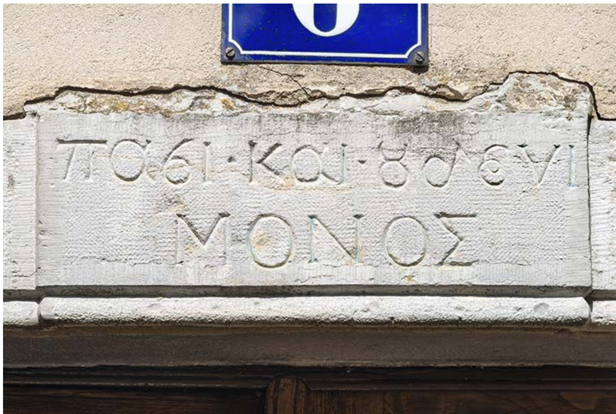
Façade sur rue. Linteau gravé.
