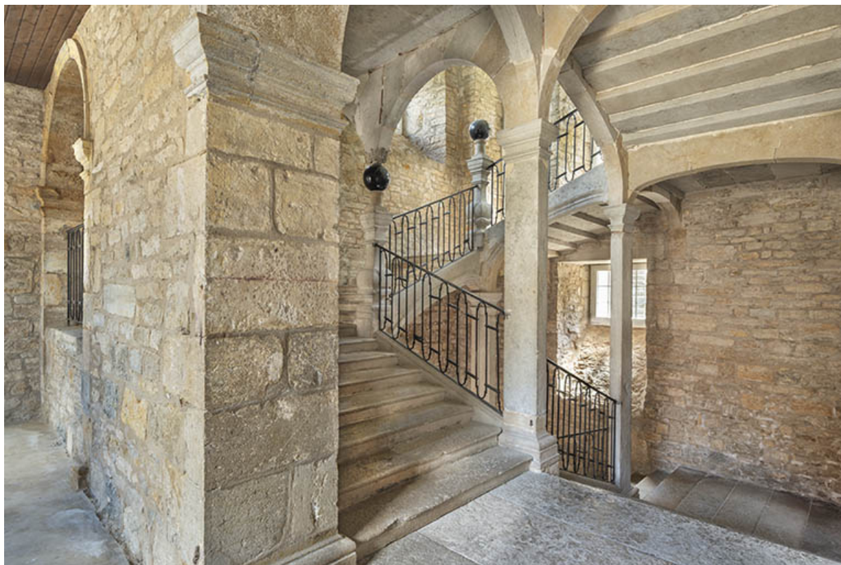
Escalier dit "aux boules de pierre". Vue depuis le dégagement au premier étage.
