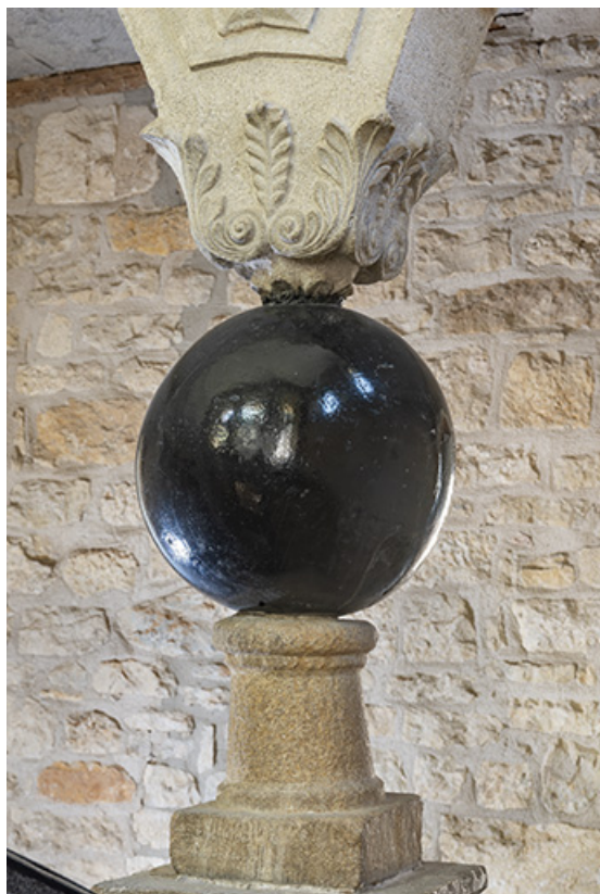
Premier étage de l'escalier dit "aux boules de pierre". Détail de la retombée d'un arc sur la sphère noire. 39, Salins-les-Bains, 9 rue du Temple
