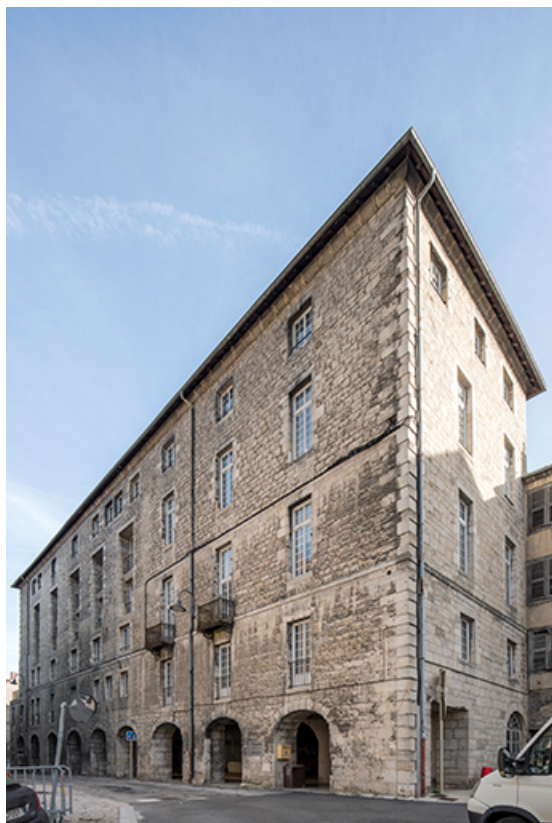
Élévation sur rue depuis le sud-ouest.
