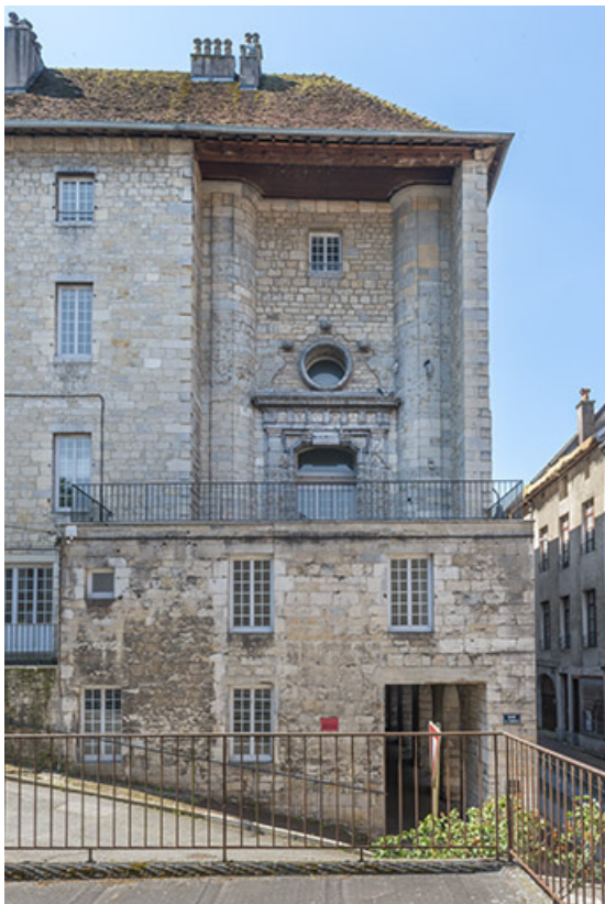
Élévation nord. Entrée de la chapelle.
