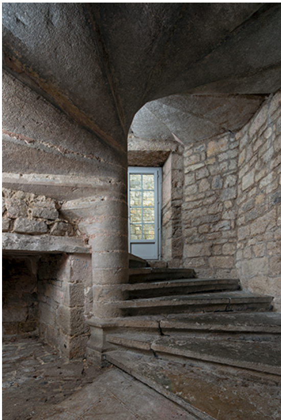
Escalier sud du bâtiment amont. Vue depuis le rez-de-chaussée.
