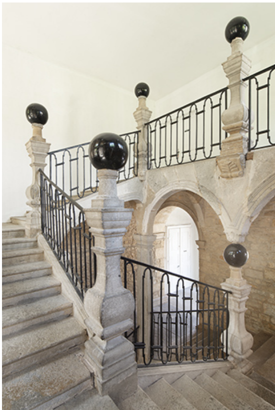
Escalier dit "aux boules de pierre". Rampe en ferronnerie et balustres entre le premier et le second étage. 39, Salins-les-Bains, 9 rue du Temple
