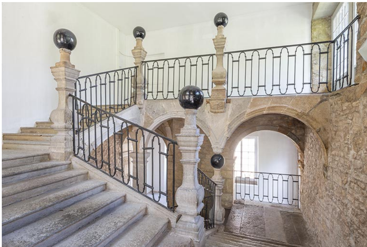
Escalier dit "aux boules de pierre". Vue depuis le deuxième palier du premier étage.
