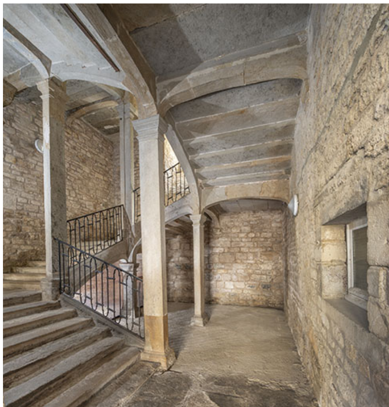
Escalier dit "aux boules de pierre". Vue depuis le rez-de-chaussée.
