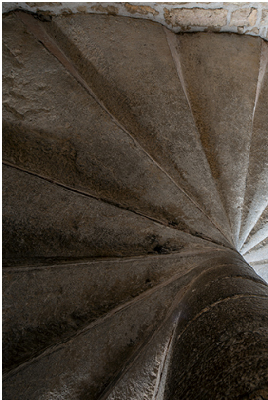
Escalier sud du bâtiment amont. Vue des volées de marche en contre-plongée.
