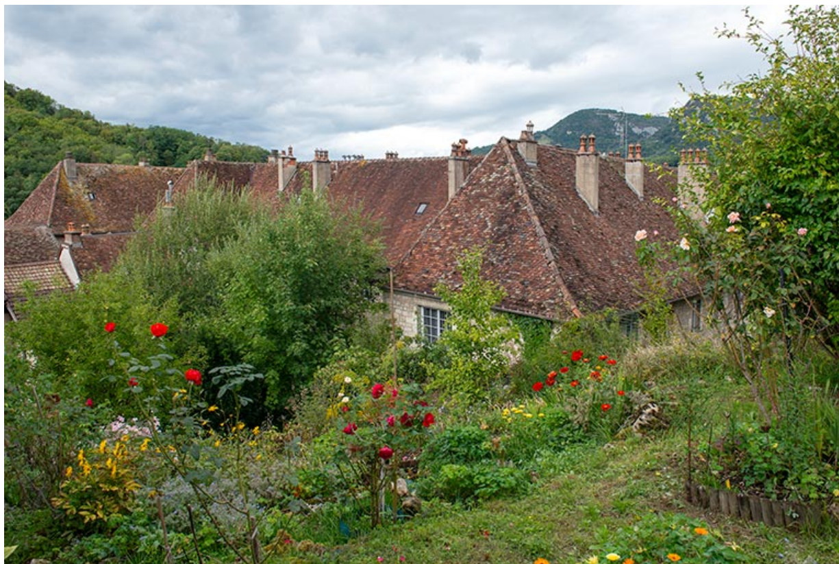
Toitures du couvent, depuis le sud-est.
