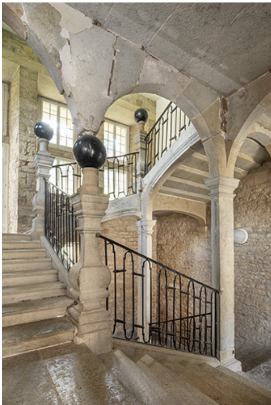
Escalier dit "aux boules de pierre". Vue de la cage depuis le premier palier du premier étage. 39, Salins-les-Bains, 9 rue du Temple
