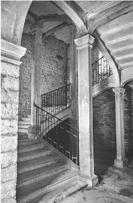
Grand escalier, s.d. [vers 1960].
