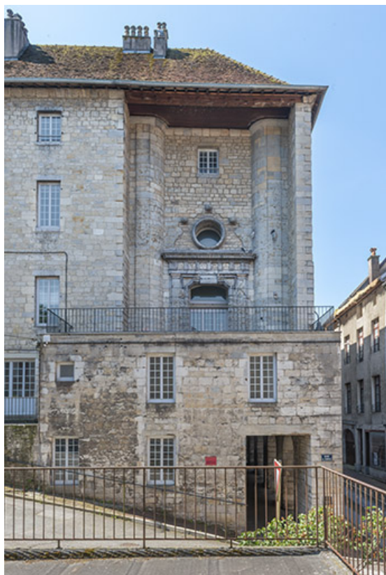
Élévation nord. Entrée de la chapelle.
