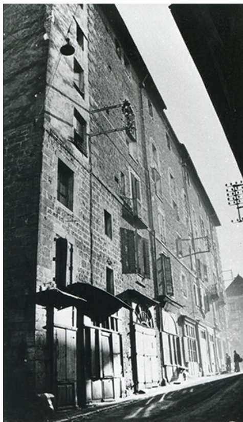
Façade ouest vue de trois quarts, s.d. [1ère moitié 20e siècle].
