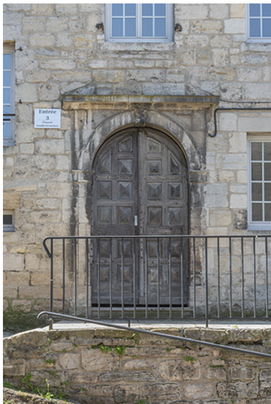
Bâtiment sur rue. Entrée de la façade nord.
