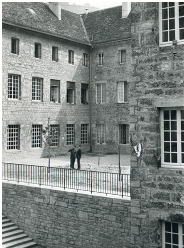
Vue sur la cour supérieure depuis le nord, s.d. [vers 1961]. 39, Salins-les-Bains, 9 rue du Temple
