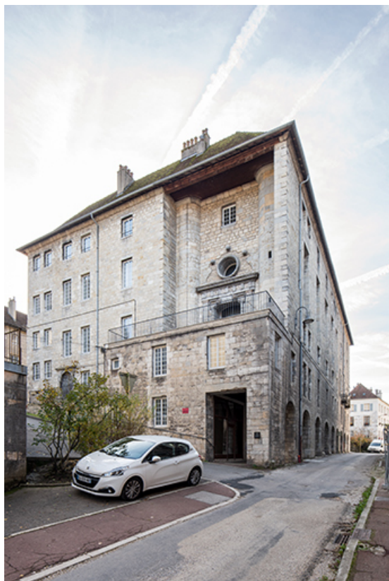
Bâtiment sur rue (ancienne chapelle du couvent), vue depuis le nord-ouest.
