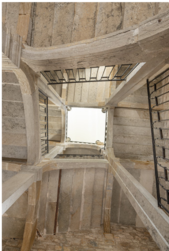
Escalier dit "aux boules de pierre". Jour central depuis le rez-de-chaussée. 39, Salins-les-Bains, 9 rue du Temple
