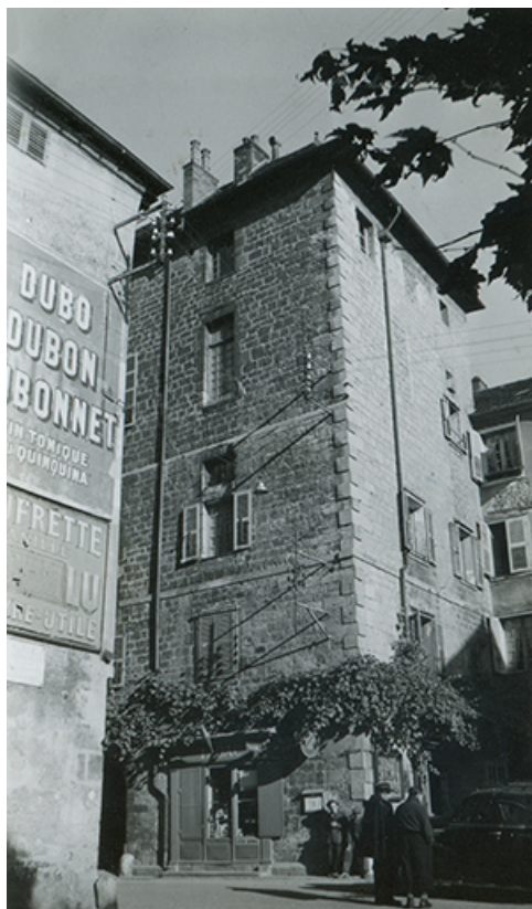
Angle sud-ouest du bâtiment sur rue, s.d. [vers 1955]. 39, Salins-les-Bains, 9 rue du Temple
