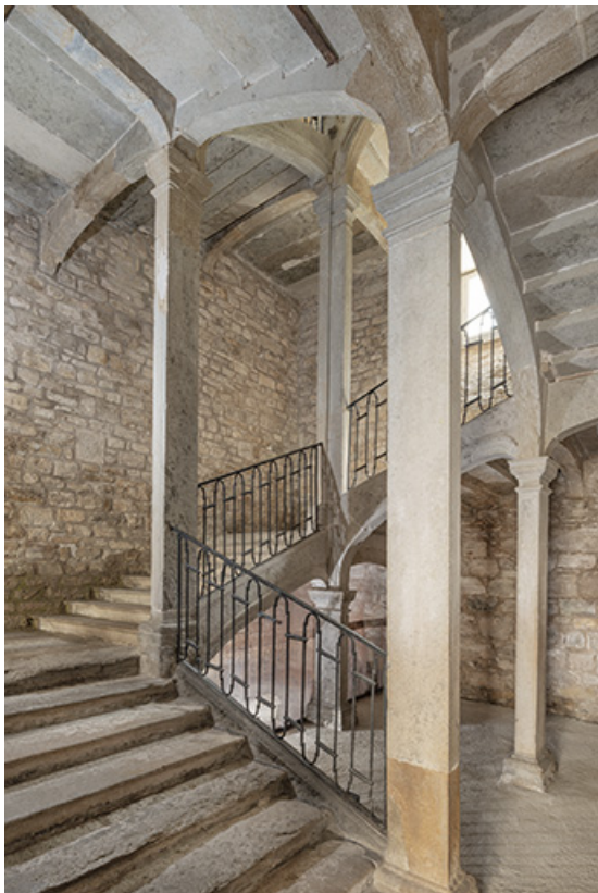
Escalier dit "aux boules de pierre". La cage vue depuis le rez-de-chaussée. 39, Salins-les-Bains, 9 rue du Temple
