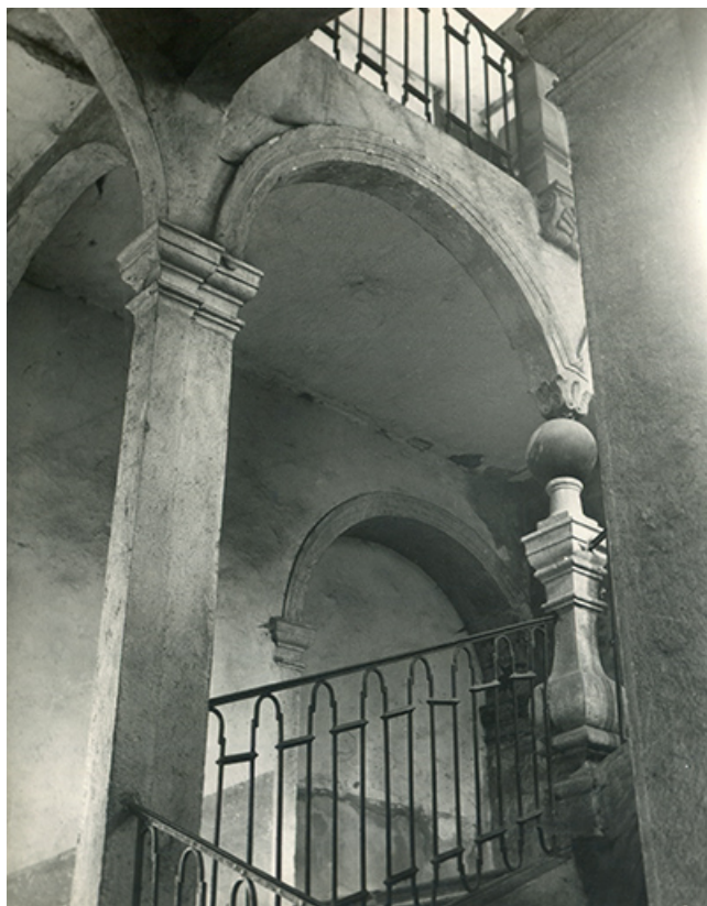
Escalier dit " aux boules de pierre ". Vue en contre-plongée, s.d. [vers 1970]. 39, Salins-les-Bains, 9 rue du Temple
