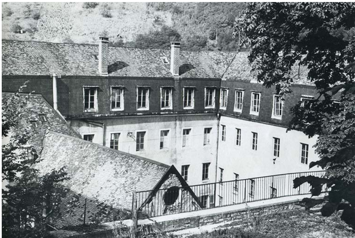
Vue sur la cour, depuis la terrasse ouest, s.d. [3e quart 20e siècle].
