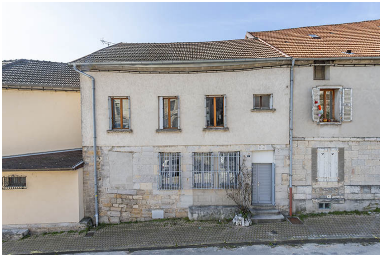
Façade est (rue Charles David).
