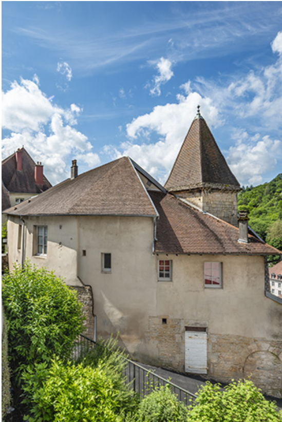
Vue plongeante depuis le nord-est.
