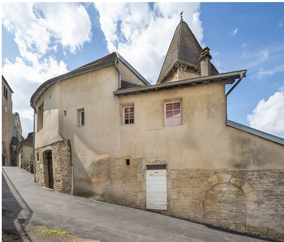
Façade nord, depuis la ruelle d'Arçon.
