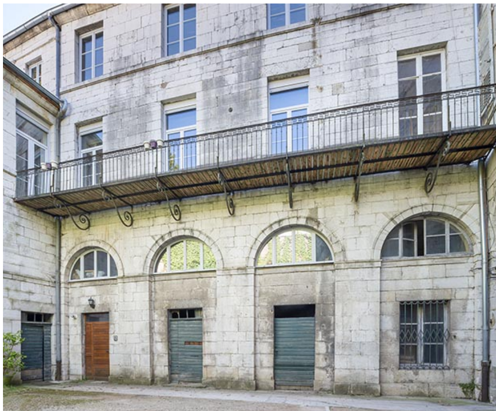
Façade de l'aile sud, depuis la cour.
