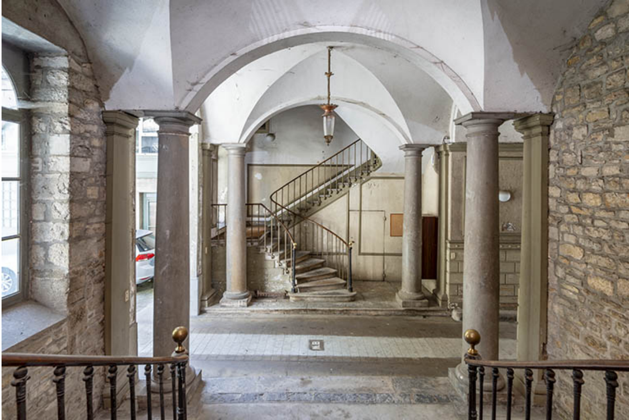
Colonnes du passage couvert et départ de l'escalier de service, depuis les marches de l'escalier d'honneur. 39, Salins-les-Bains, 73 rue de la République
