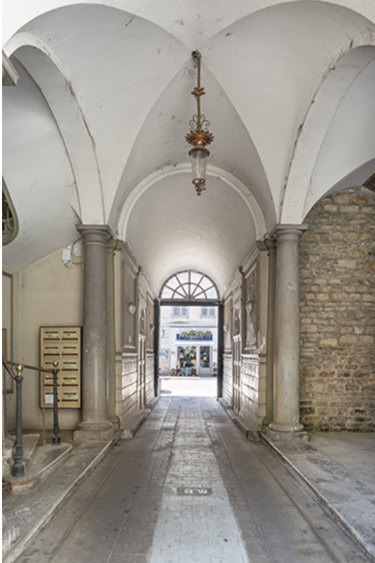
Vue du passage couvert depuis l'entrée de la cour.
