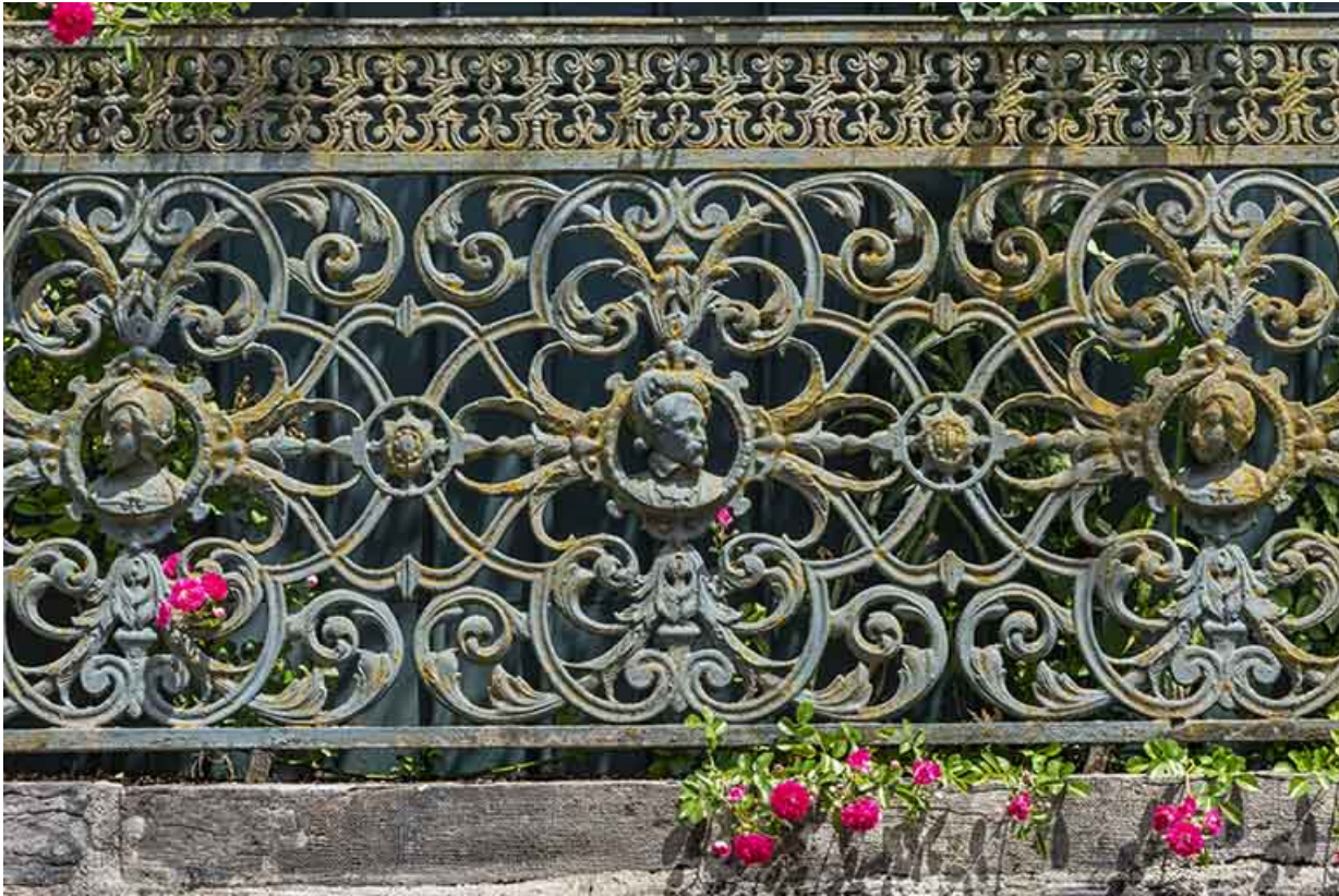
Mur ouest du jardin. Détail de la grille.
