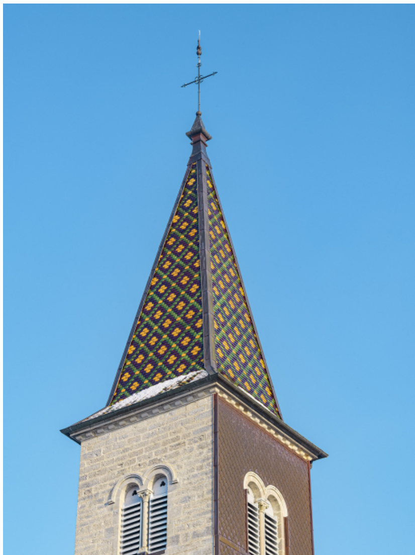
Baies géminées et flèche du clocher.
