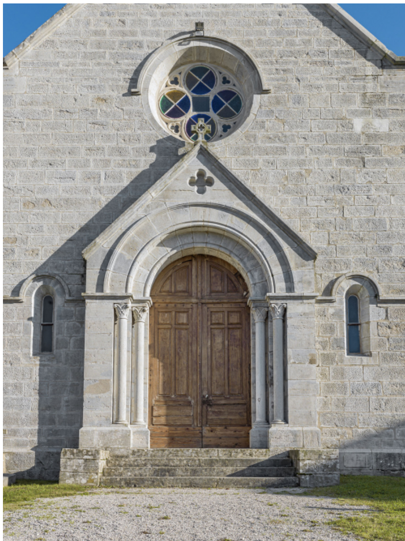
Façade principale, détail : portail.
