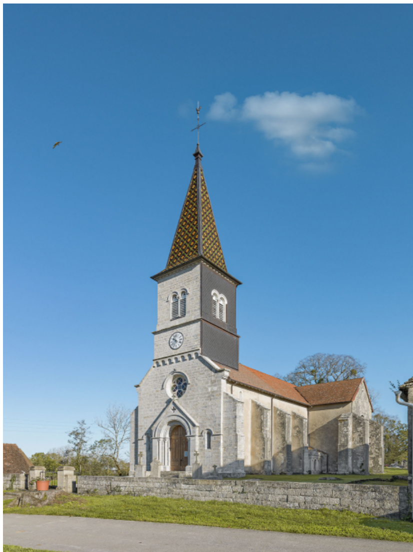
Façade principale et élévation sud.
