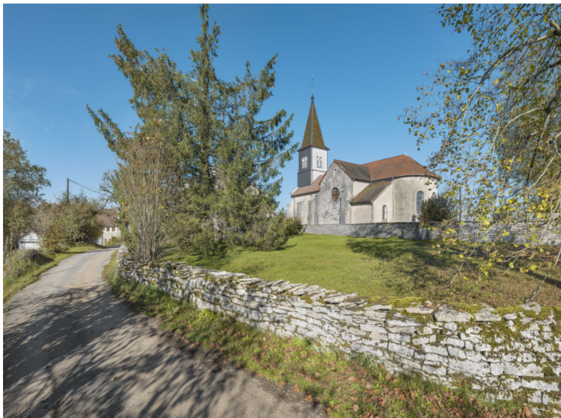
Vue d'ensemble : élévation sud et chevet.
