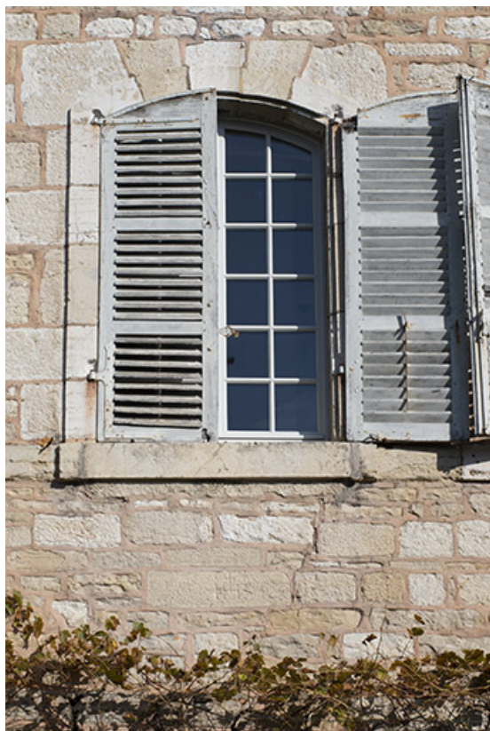
Fenêtre du rez-de-chaussée (façade ouest).
