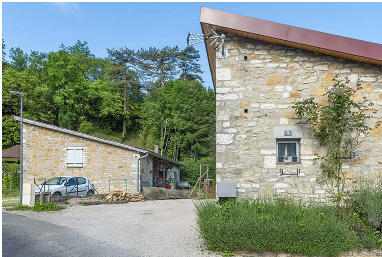
Pignons des maisons depuis l'entrée de la rue. 39, Salins-les-Bains, 1-8 rue des Cités Saint-Pierre
