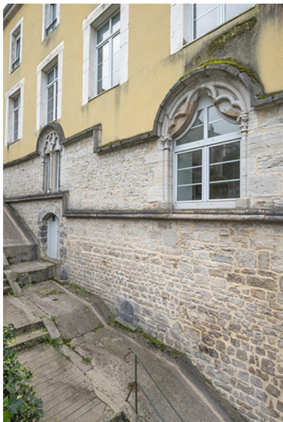
Partie basse de la façade nord, vue de trois quarts droite.
