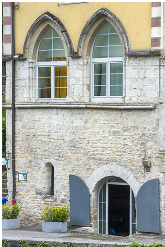
Façade ouest, vue de trois quarts droite.
