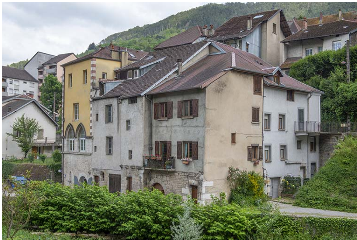
Vue d'ensemble depuis le sud-ouest (immeuble à gauche).
