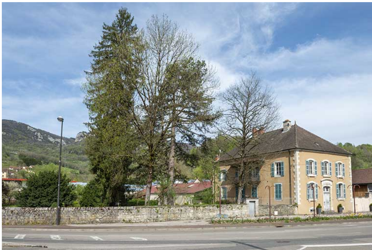
Vue d'ensemble depuis l'ouest. A gauche, le parc.
