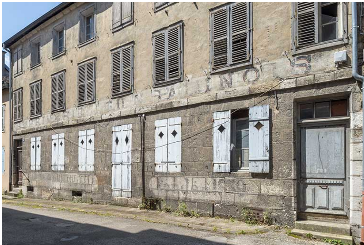
Façade postérieure (rue d'Orgemont). Partie inférieure.
