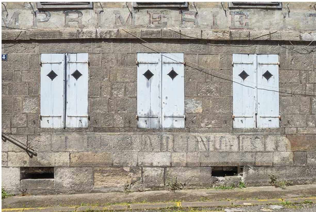
Façade rue d'Orgemont. Rez-de-chaussée des travées sud.
