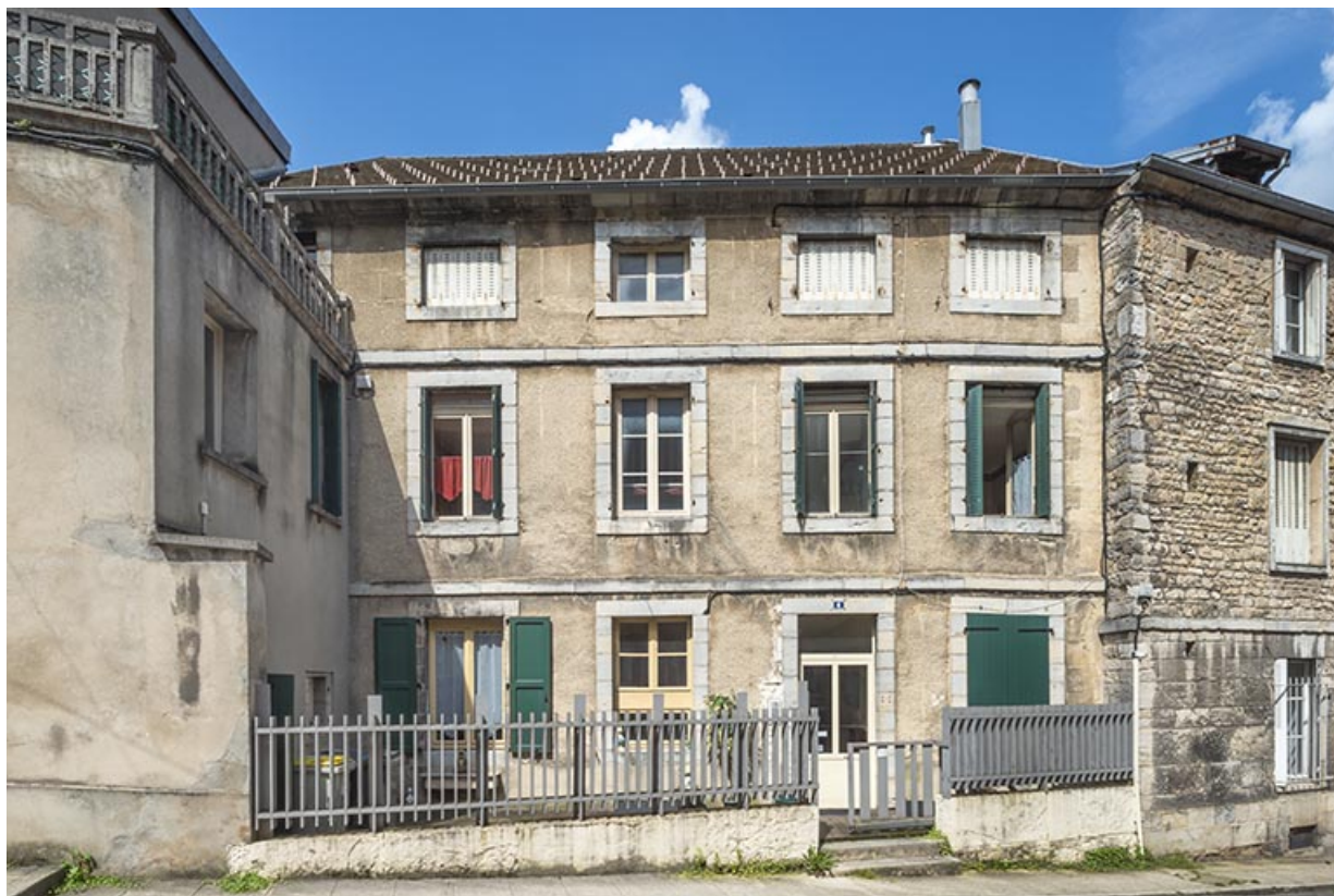
Façade postérieure (rue Charles David).
