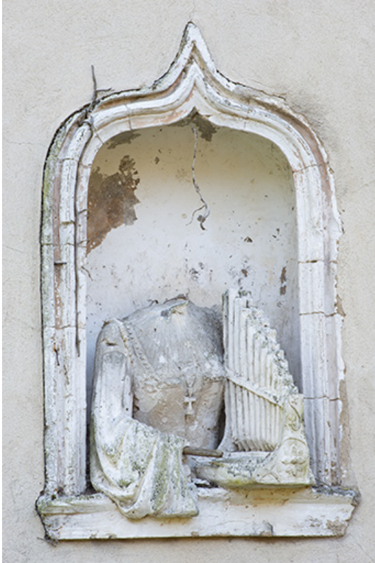
Façade nord. Niche en plâtre et statue de Sainte-Barbe.
