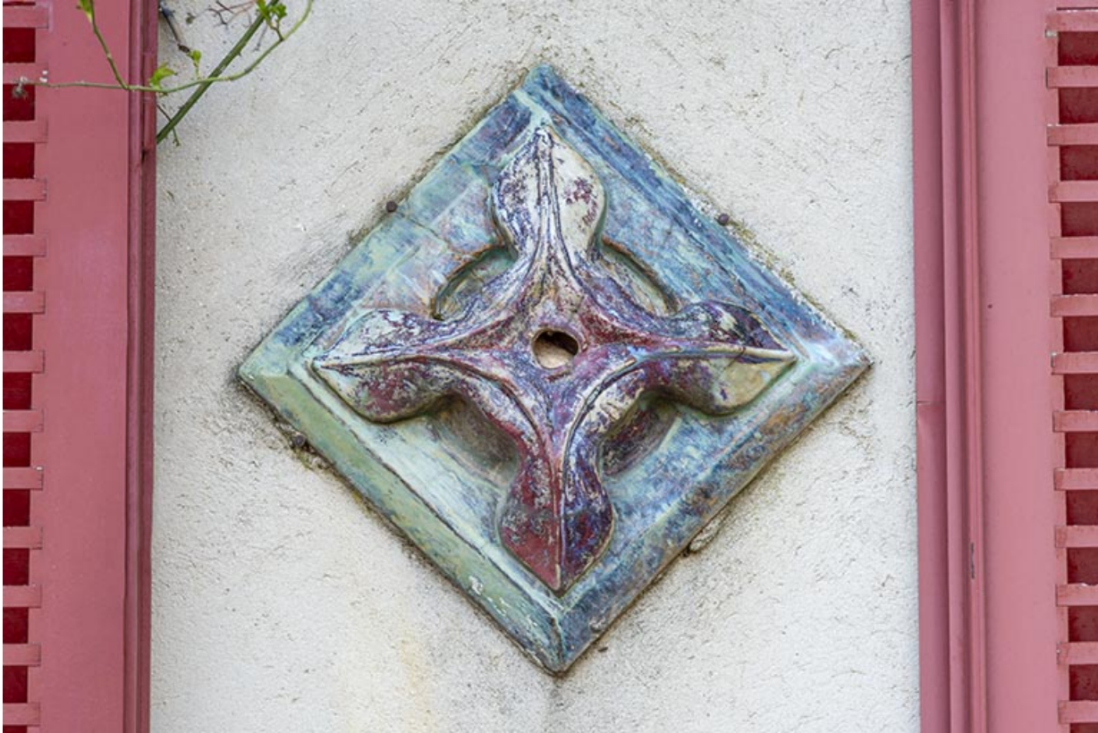
Façade ouest du logement. Détail d'un caboçon.
