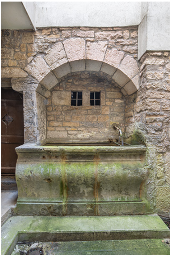
Bassin de fontaine dans la cour.
