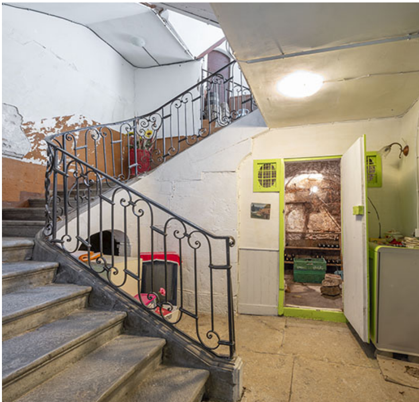
Cage d'escalier, depuis le rez-de-chaussée.
