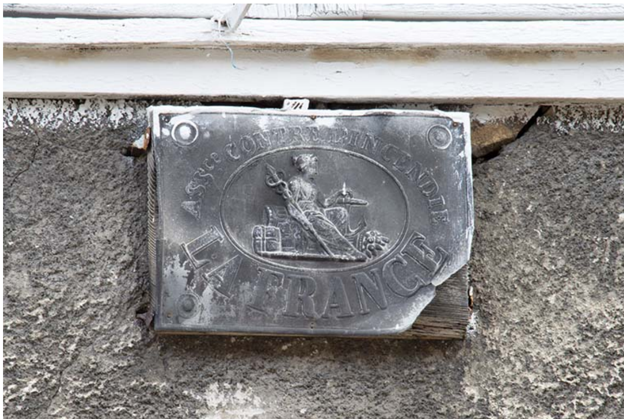
Façade sur la rue Charles Magnin (étage supérieur). Plaque d'assurance La France. 39, Salins-les-Bains, 14 rue Charles Magnin
