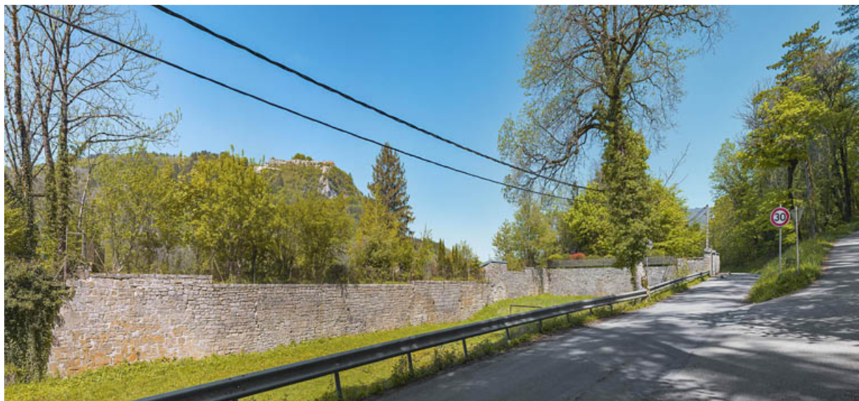
Bourg : mur de l'ancienne enceinte fortifiée.
