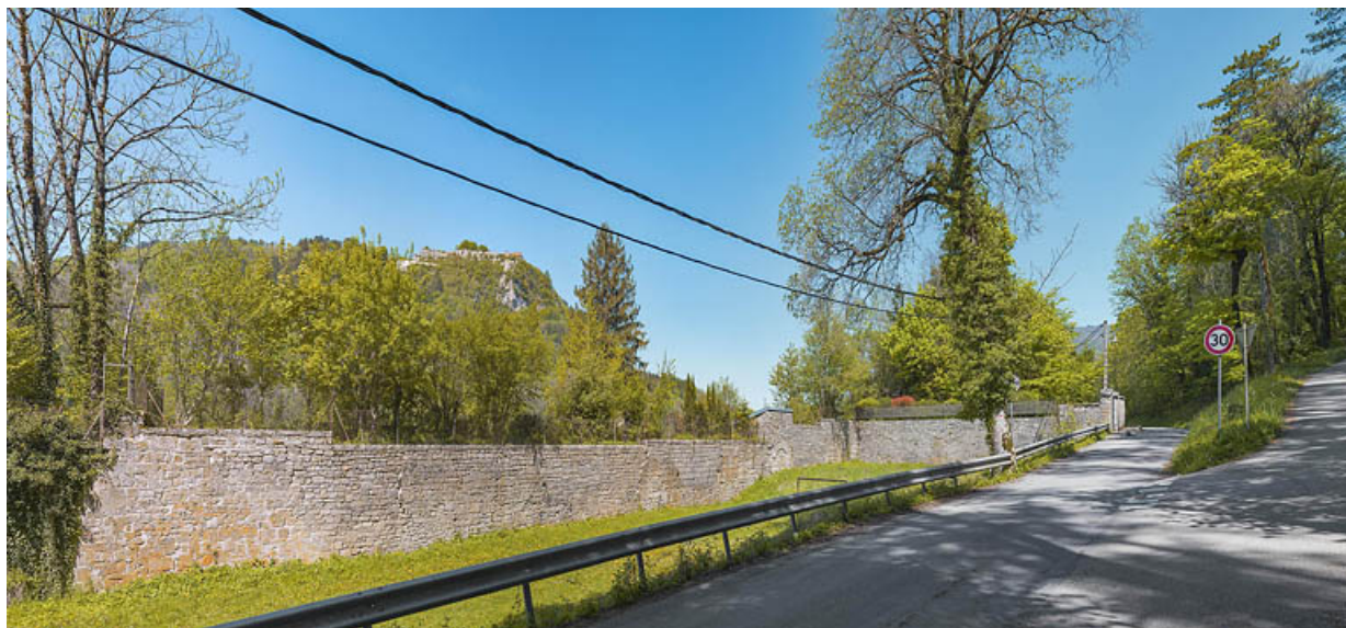
Bourg : mur de l'ancienne enceinte fortifiée.
