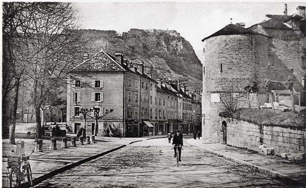
601 SALINS-les-BAINS (altit. 345 m) - Entrée de la ville du côté sud, porte Oudin David-Mauvas, éditeur
