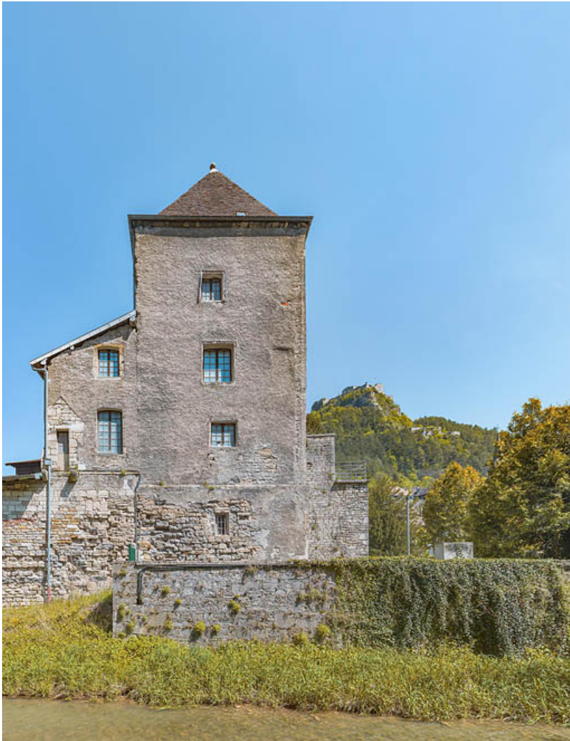
Façade ouest de la tour de Reculot. 39, Salins-les-Bains
