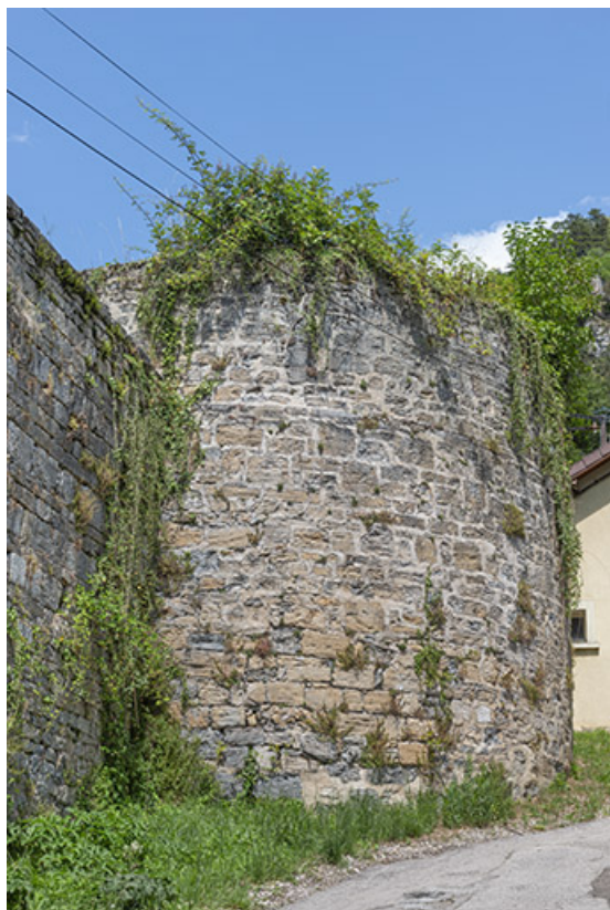
Tour Rouge (front sud). 39, Salins-les-Bains
