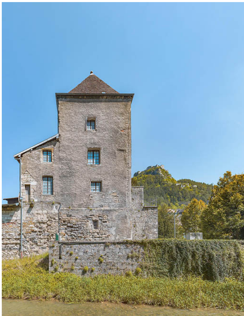
Façade ouest de la tour de Reculot.
