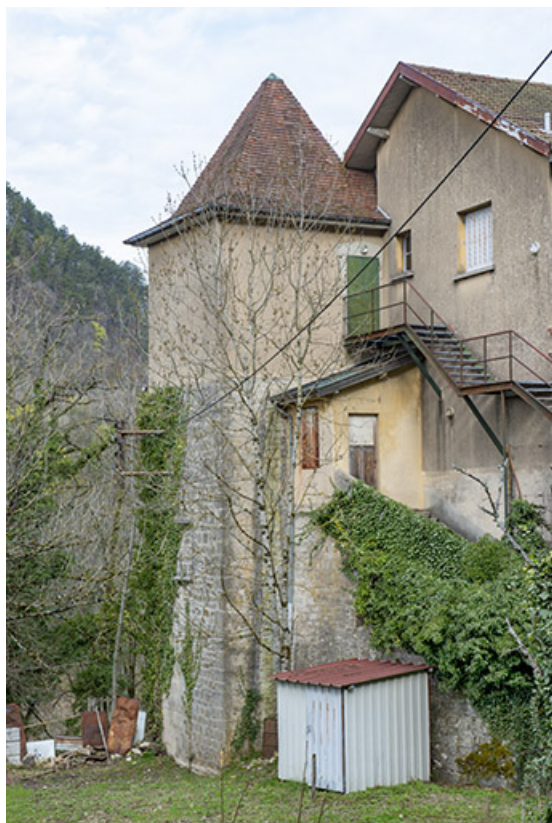
Tour Terrestre, depuis l'est.
