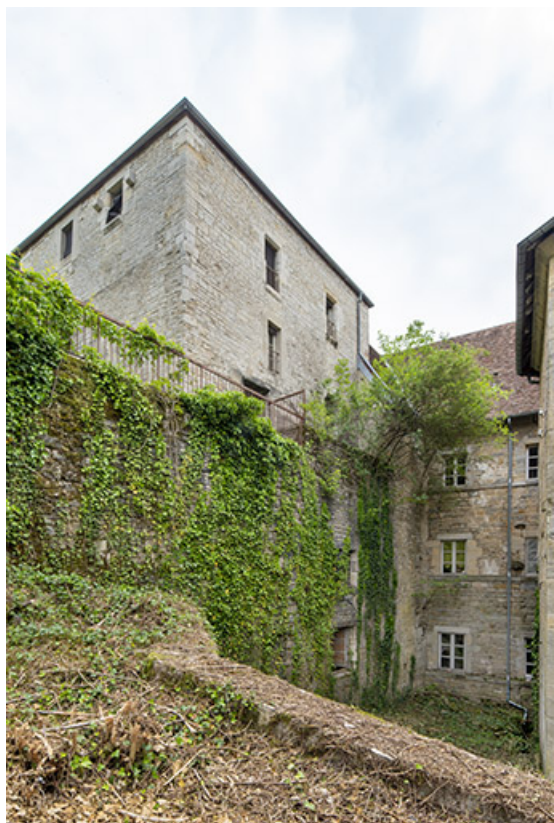
La tour Dorée, vue en contre-plongée depuis le sud-ouest. 39, Salins-les-Bains
