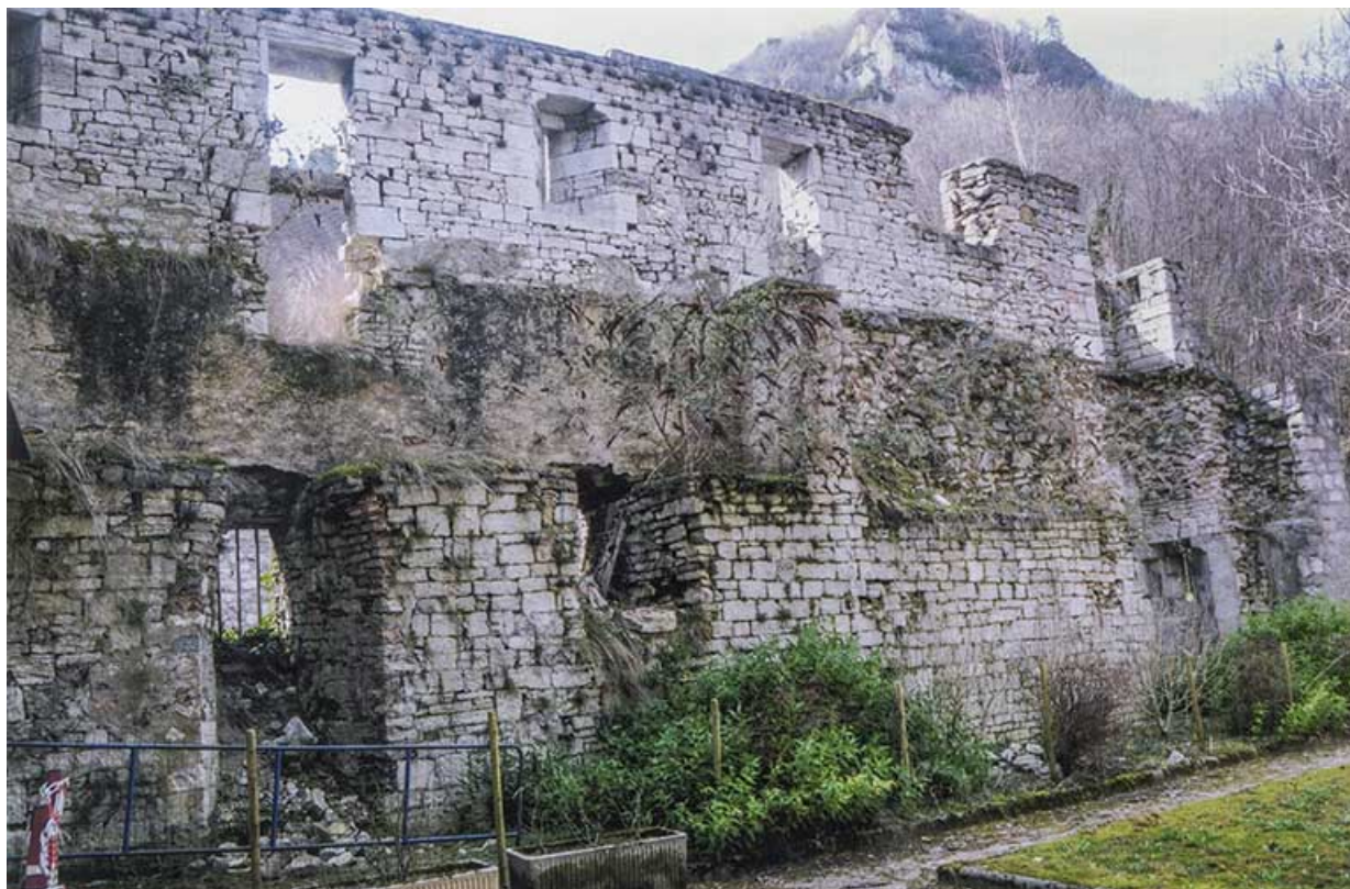
Face interne du rempart conservé au nord du pont Saint-Nicolas, 2011. 39, Salins-les-Bains
