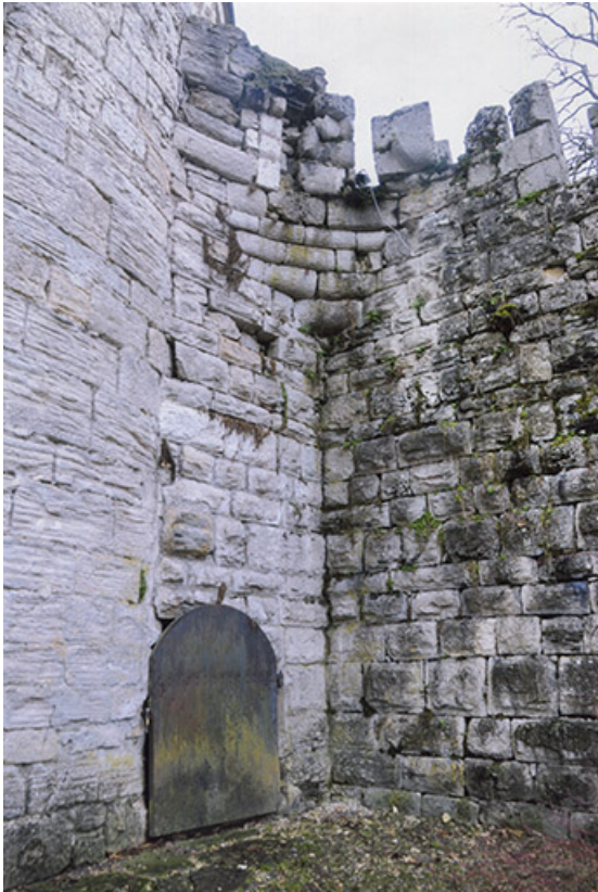
Jonction de la tour d'Andelot et de la courtine nord, 2011. 39, Salins-les-Bains
