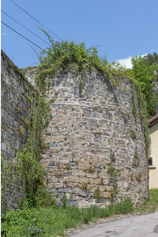
Tour Rouge (front sud). 39, Salins-les-Bains
