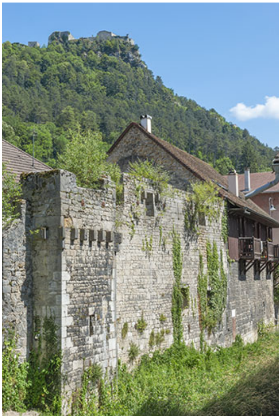
Rempart et tour en aval de la porte Saint-Nicolas. 39, Salins-les-Bains
