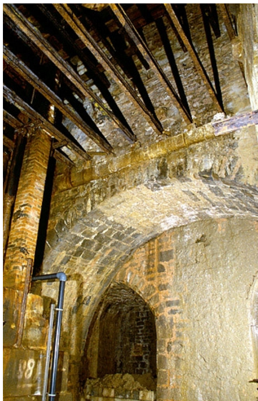
Angle nord-ouest du puits à Muire en contre-plongée. 39, Salins-les-Bains, 2 place des Alliés et de la Résistance
