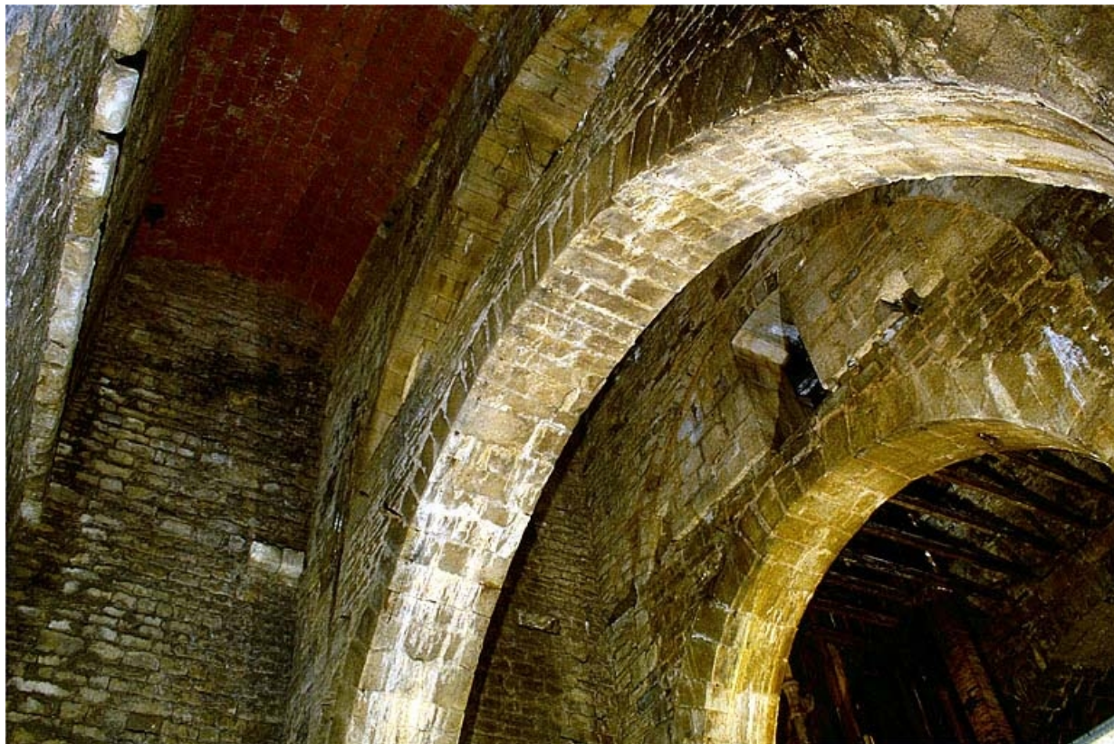
Arcs-diaphragmes et voûtement du puits à Muire.
