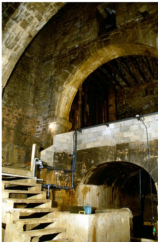
Au centre, bassin de stockage de l'eau salée pour l'établissement thermal. 39, Salins-les-Bains, 2 place des Alliés et de la Résistance
