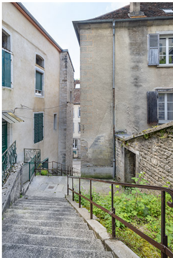
Façade nord (à gauche) depuis l'escalier des Sires de Poupet.
