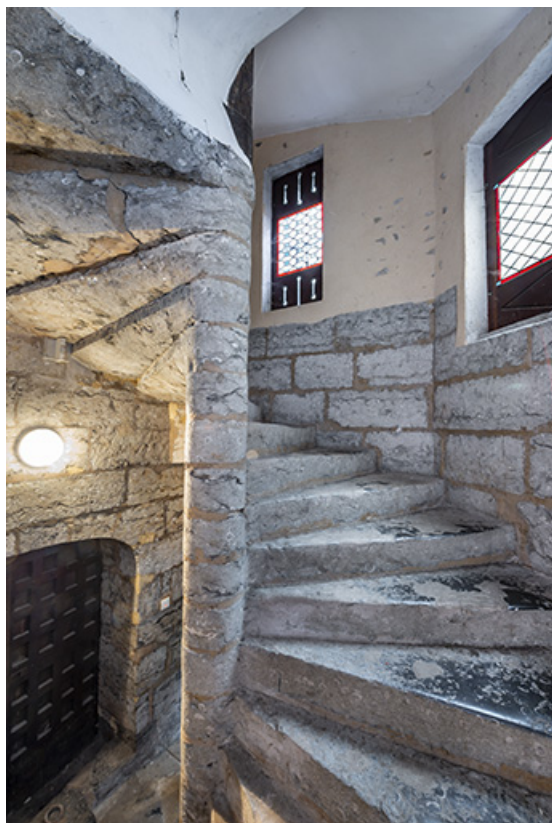
Escalier en vis : accès au premier étage.
