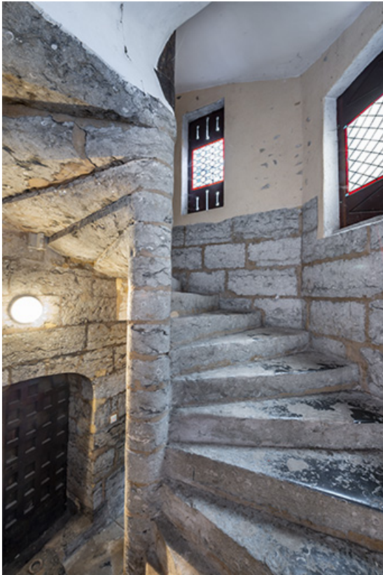
Escalier en vis : accès au premier étage.
