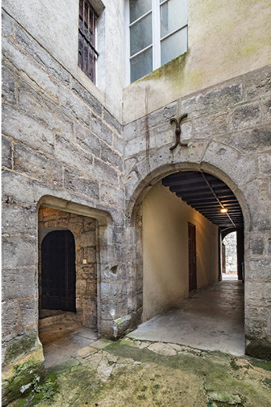
Vue de puis la cour : accès à la tour d'escalier et au couloir d'entrée. 39, Salins-les-Bains, 37 rue de la Liberté
