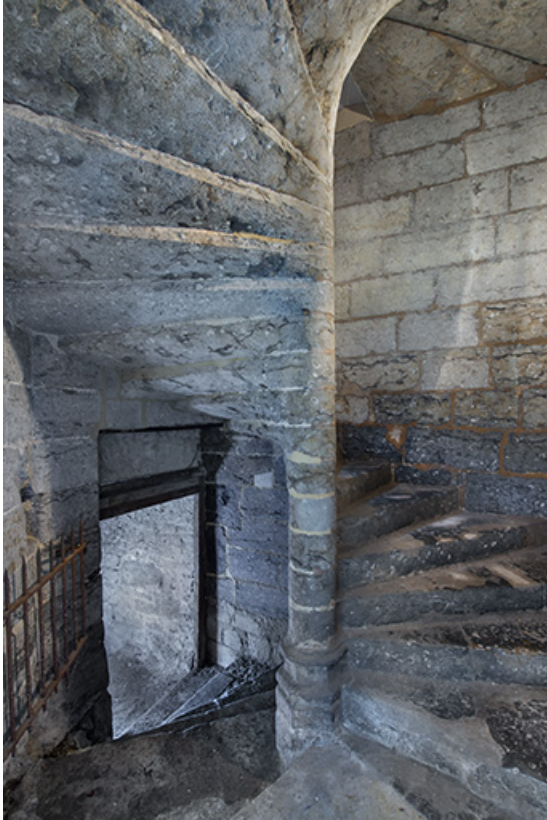
Escalier en vis : départ de la cave.
