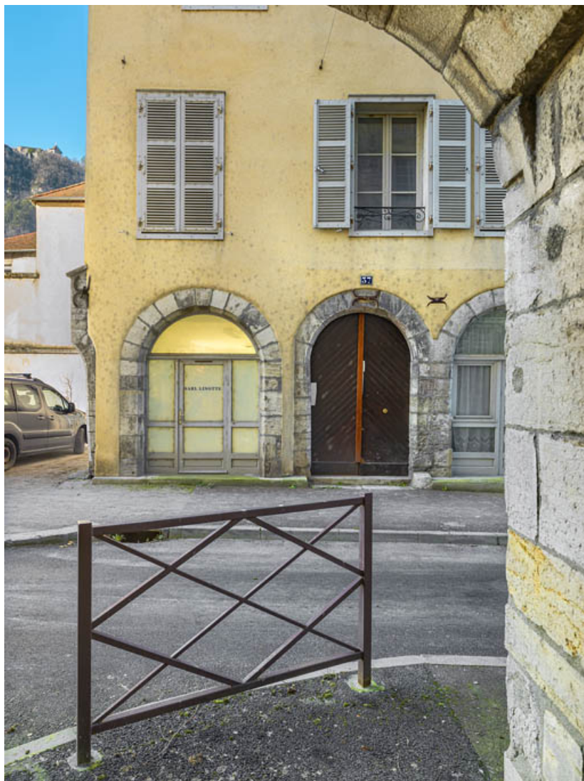
Façade antérieure du bâtiment sur rue. Partie sud.
