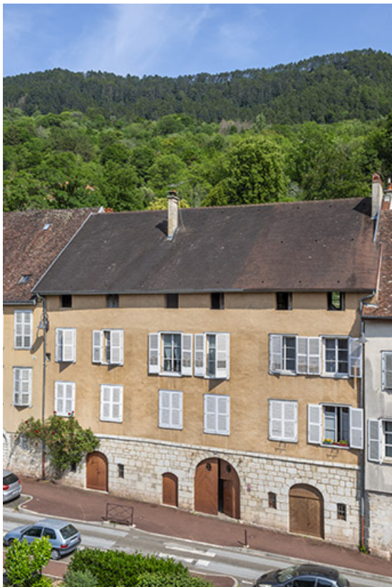
Façade antérieure vue depuis l'ouest.
