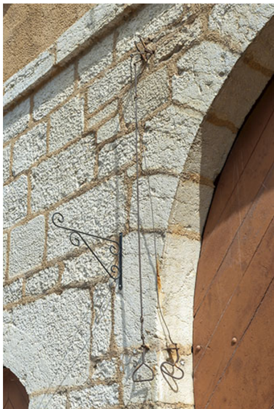
Système de sonnette (clochette) de portes intérieures depuis la rue (poignées, relais et fil de fer). 39, Salins-les-Bains, 86 rue de la Liberté
