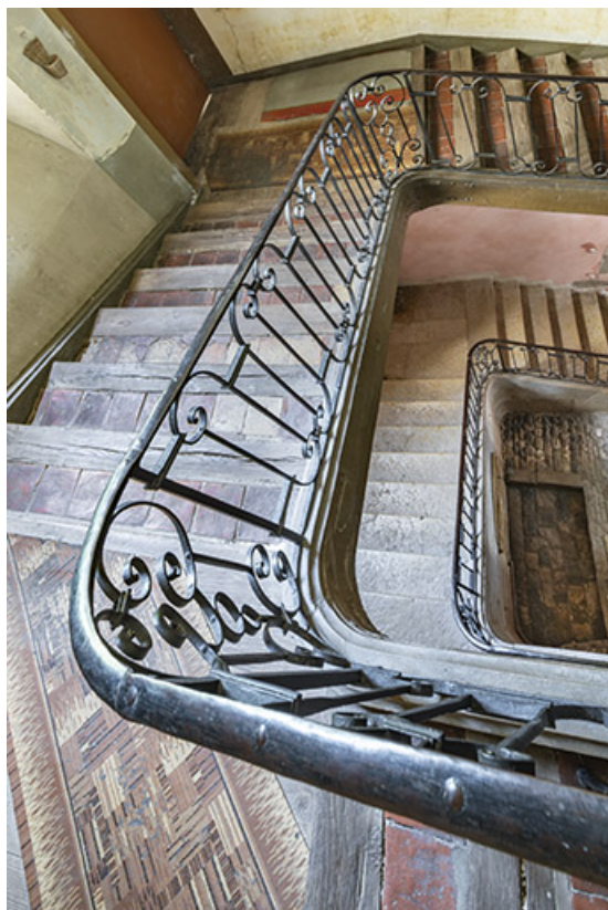
Vue plongeante sur la cage d'escalier.
