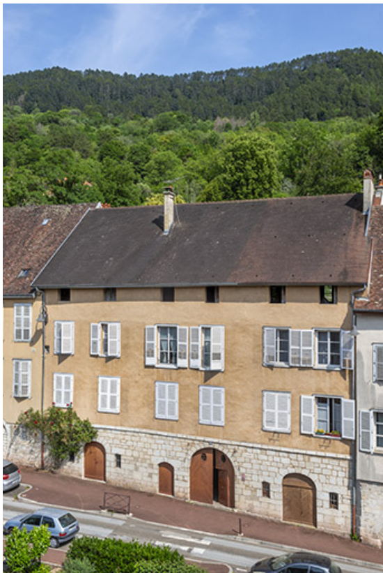
Façade antérieure vue depuis l'ouest.
