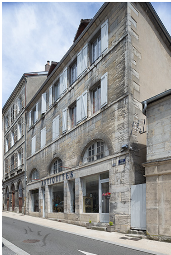
Façade vue de trois quarts droite.
