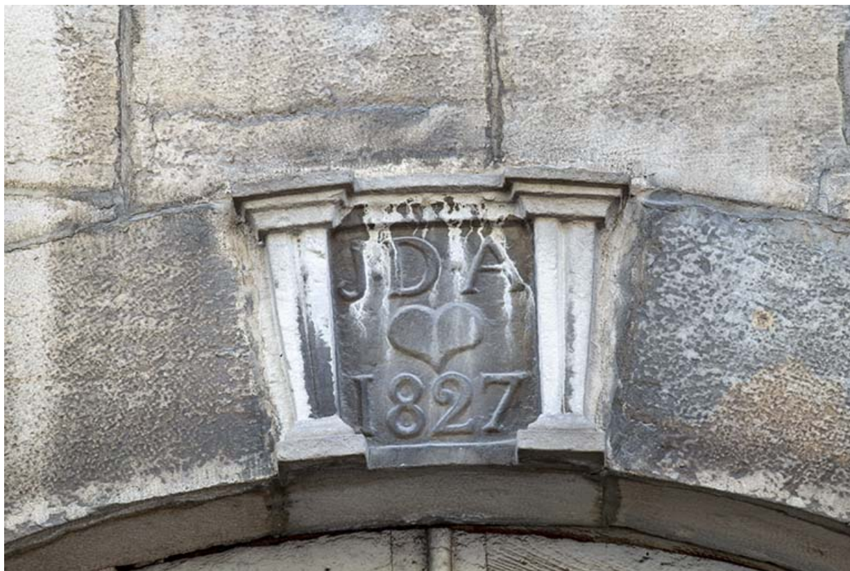
Façade antérieure. Claf de l'arcade centrale.
