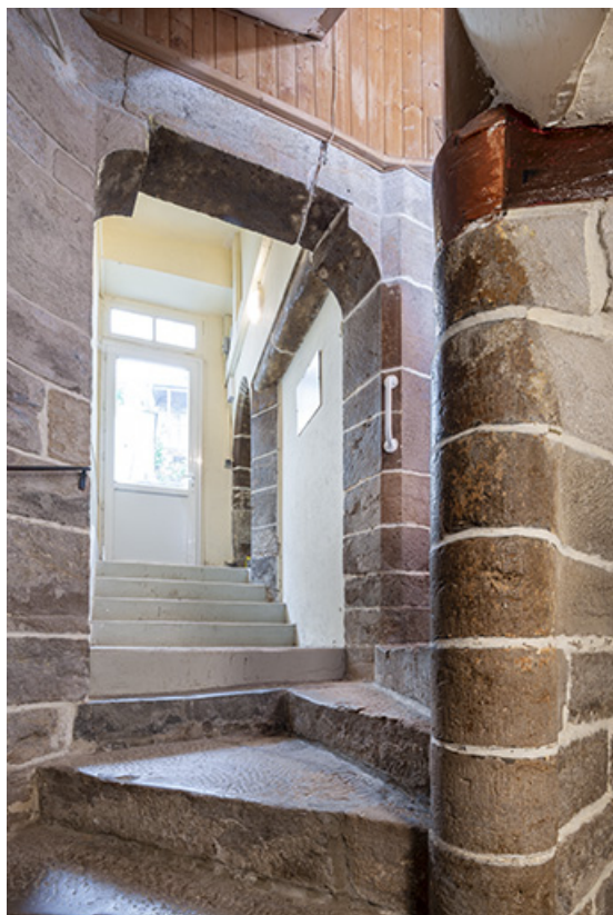
Escalier en vis et porte ouvrant sur l'entresol.
