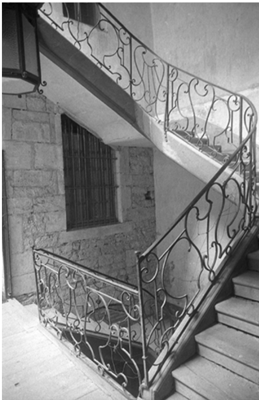
Cage d'escalier. Le second étage, s.d. [vers 1960]. 39, Salins-les-Bains, 18 rue de la Liberté
