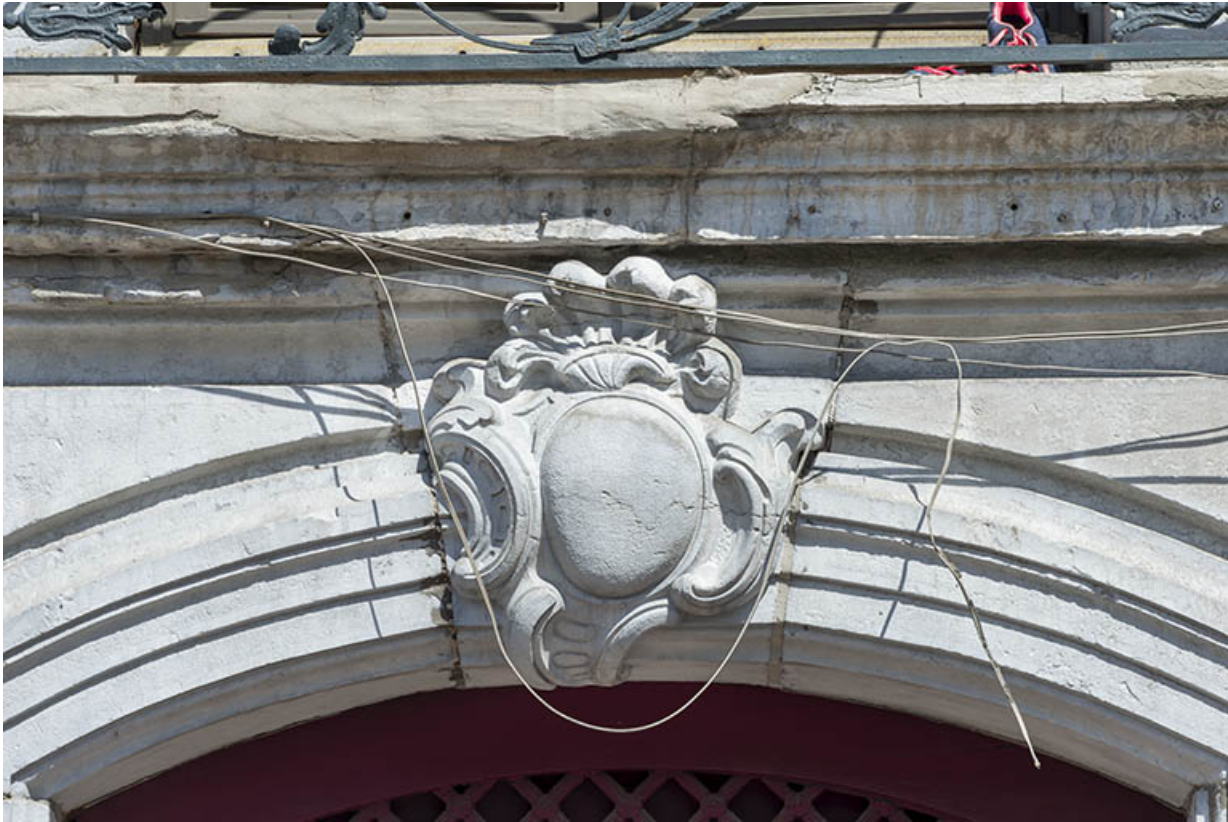
Porte principale. Détail de la clef de l'arc segmentaire.
