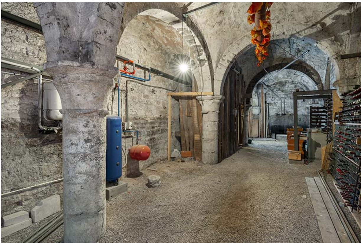
Cave vue de trois quarts, depuis l'ouest.
