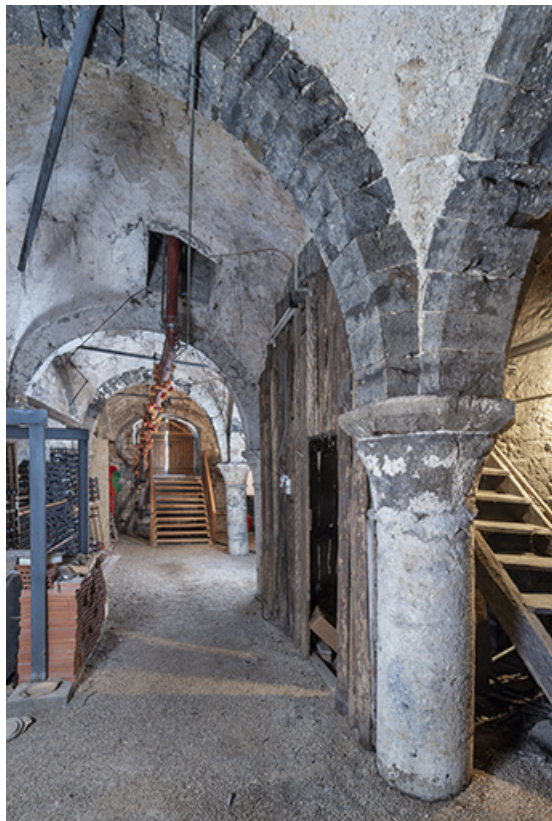
Vue d'ensemble de la cave, depuis l'est.
