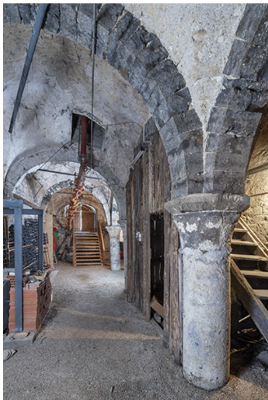
Vue d'ensemble de la cave, depuis l'est.
