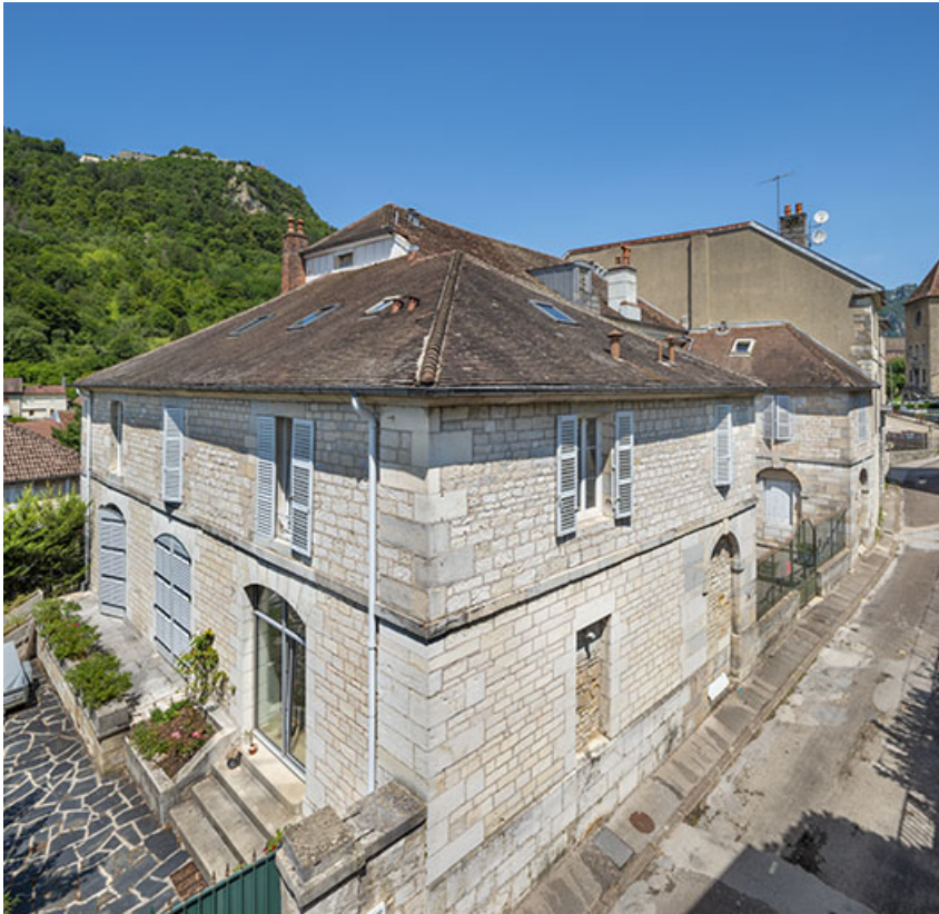
Vue plongeante depuis le sud-est.
