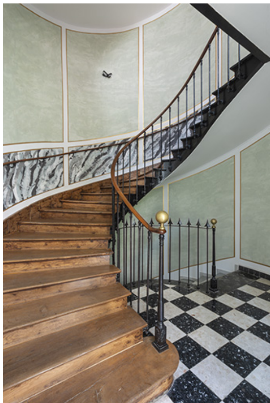
Escalier principal (aile sud). La première volée.
