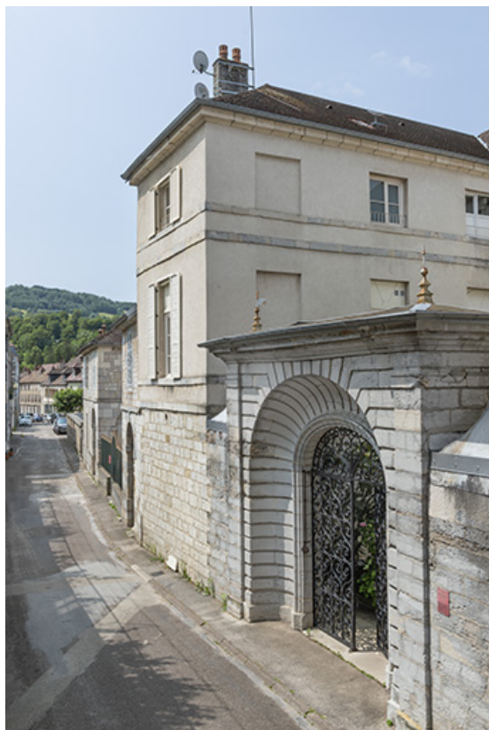
Vue plongeante depuis le nord-est.
