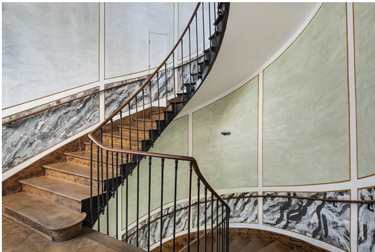
Escalier principal (aile sud). Vue depuis le premier étage.
