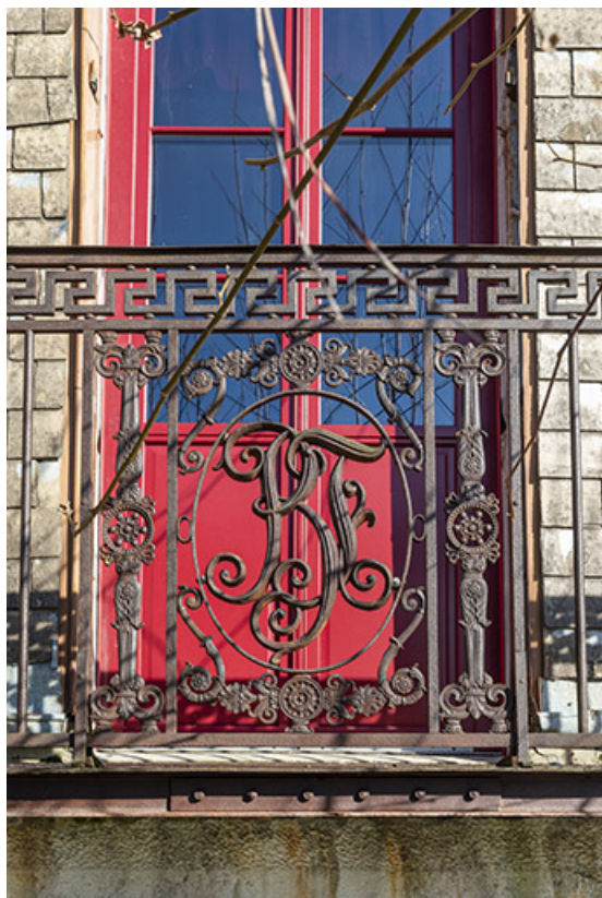
Détail du garde-corps du premier étage.
