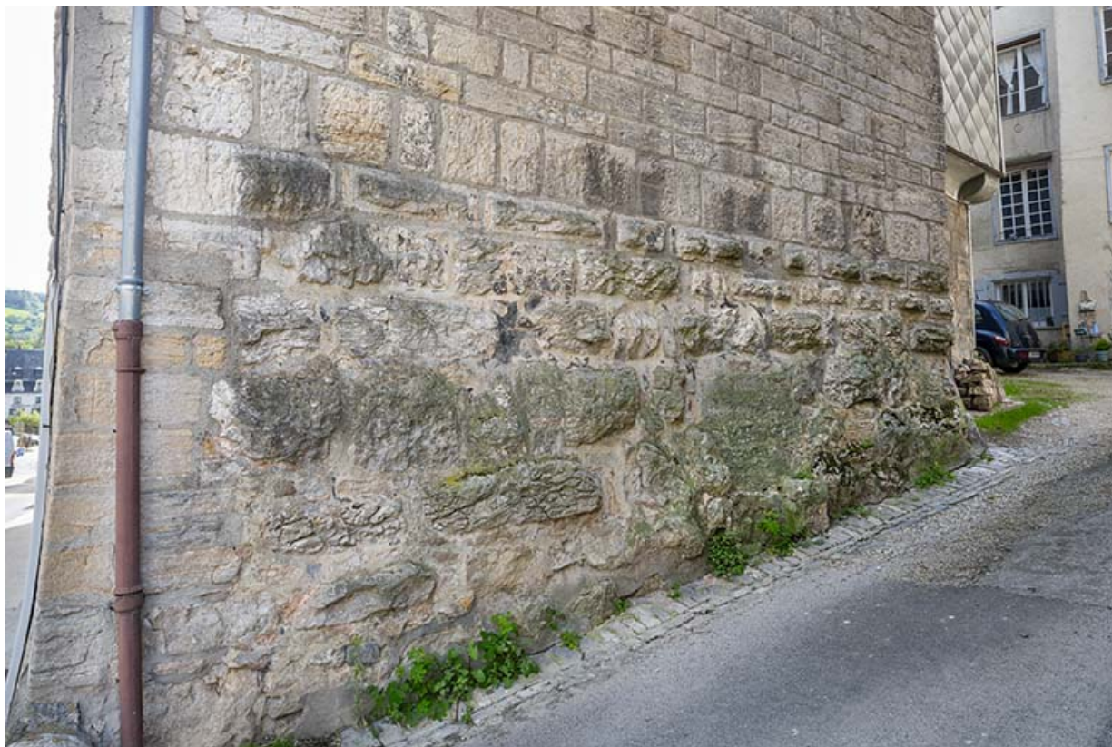
Base du mur nord (bossage en boules ?).
