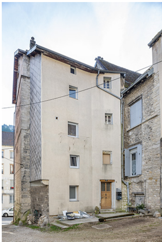
Façades postérieures des deux maisons depuis la cour des Halles.
