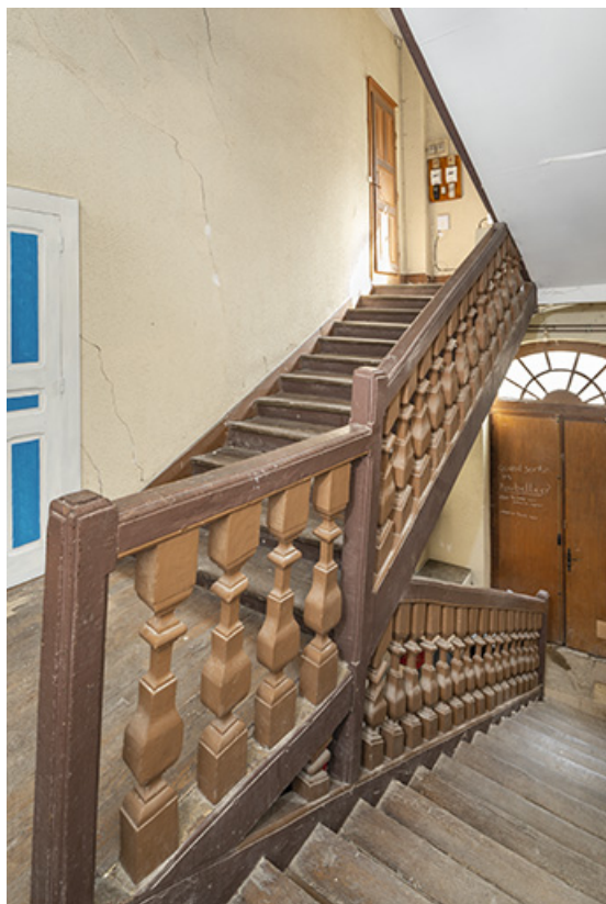
Escalier (n°3). Vue depuis l'entresol.
