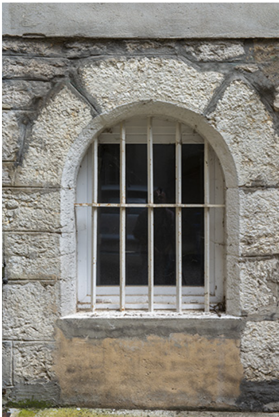
Façade est. Baie en plein-cintre du rez-de-chaussée.
