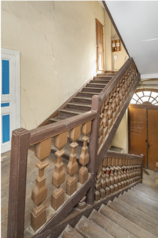
Escalier (n°3). Vue depuis l'entresol.
