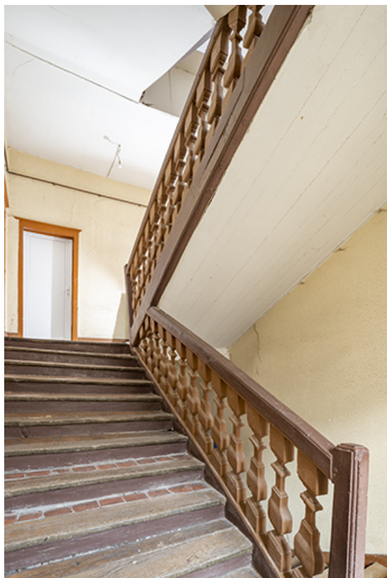
Escalier (n°3). Vue depuis le premier étage.
