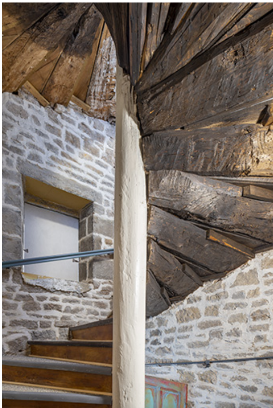
Escalier en vis (entrée n°1 cour des Halles). Détail des marches.
