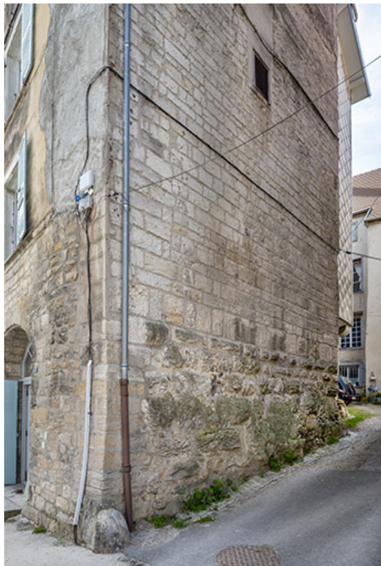
Façade nord du n°17.
