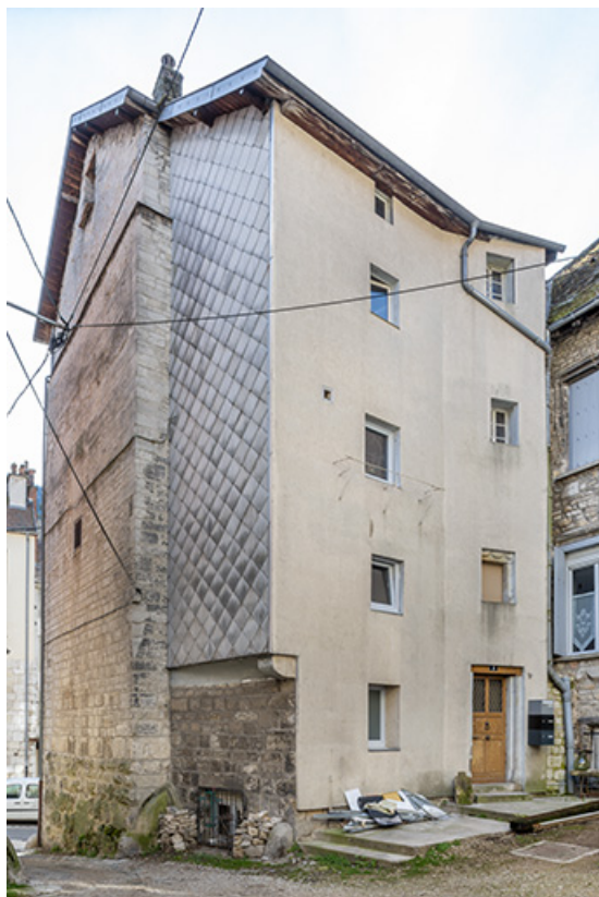
Façade postérieure (n°17) depuis la cour des Halles.
