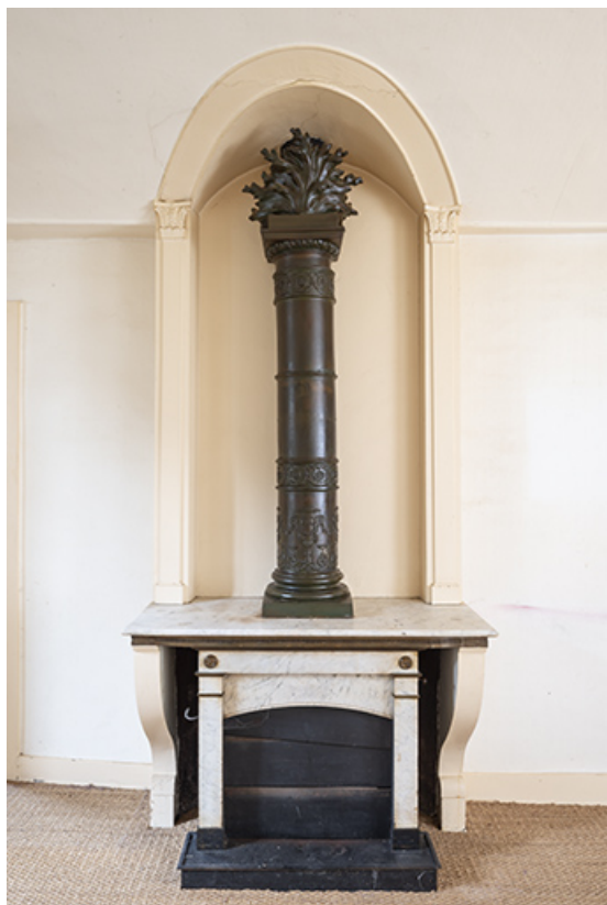
Aile nord. Cheminée (deuxième étage). 39, Salins-les-Bains, 13 rue de la Liberté
