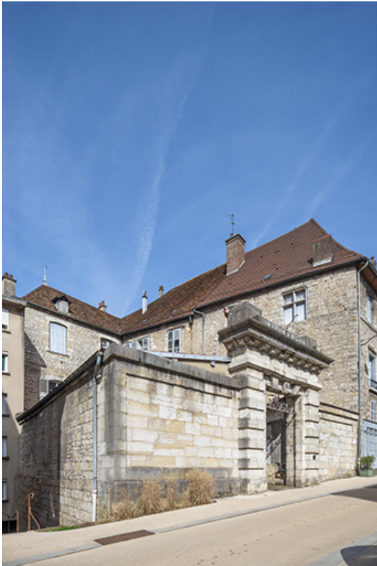
Vue de trois quarts depuis la rue.
