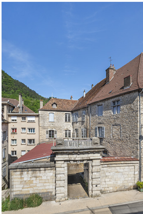
Vue plongeante d'ensemble depuis l'est.
