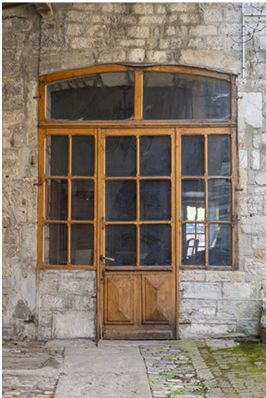
Porte gauche sur cour (mur est).
