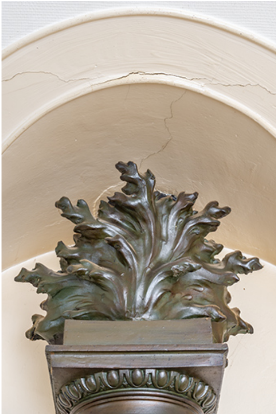
Cheminée. Couronnement du conduit d'évacuation (grès flammé).
