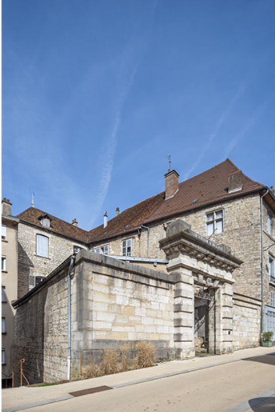
Vue de trois quarts depuis la rue.
