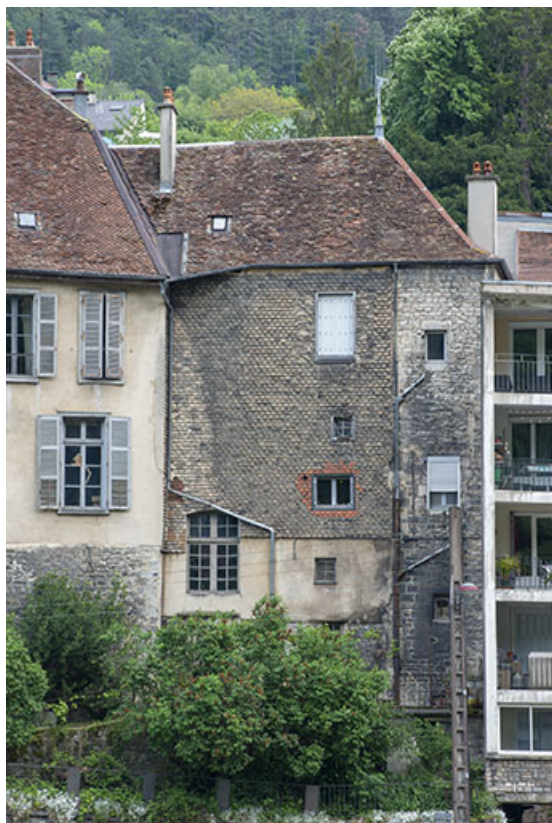
Extrémité sud de la façade occidentale.
