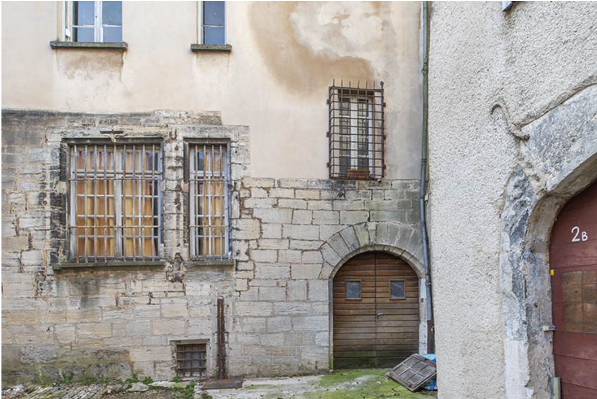
Alle nord. Premiers niveaux, depuis la cour des halles.
