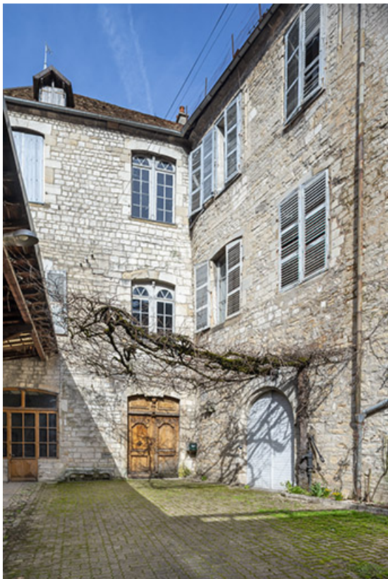
Façades est et sud depuis la cour.
