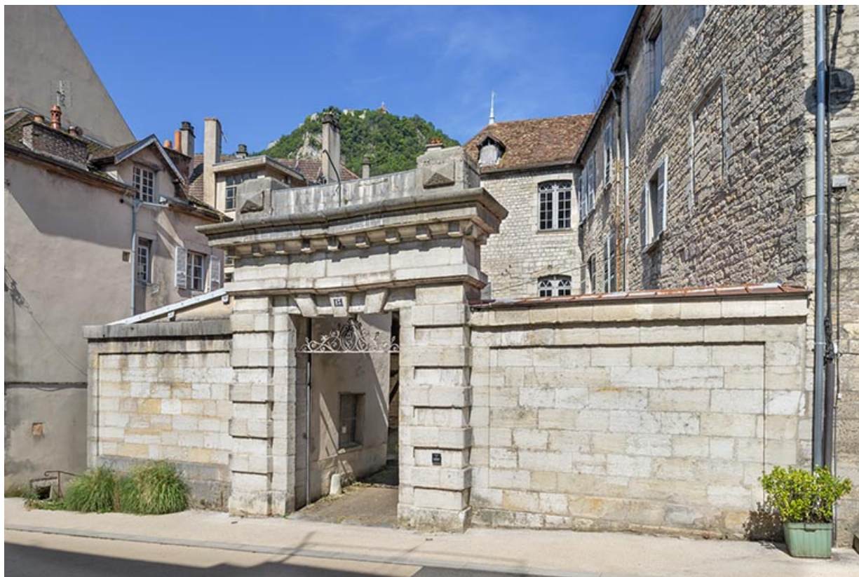
Le mur sur rue et la porte monumentale, vus de trois quarts.
