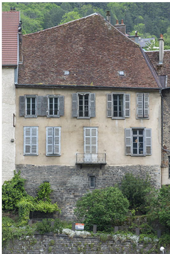
Extrémité nord de la façade occidentale.
