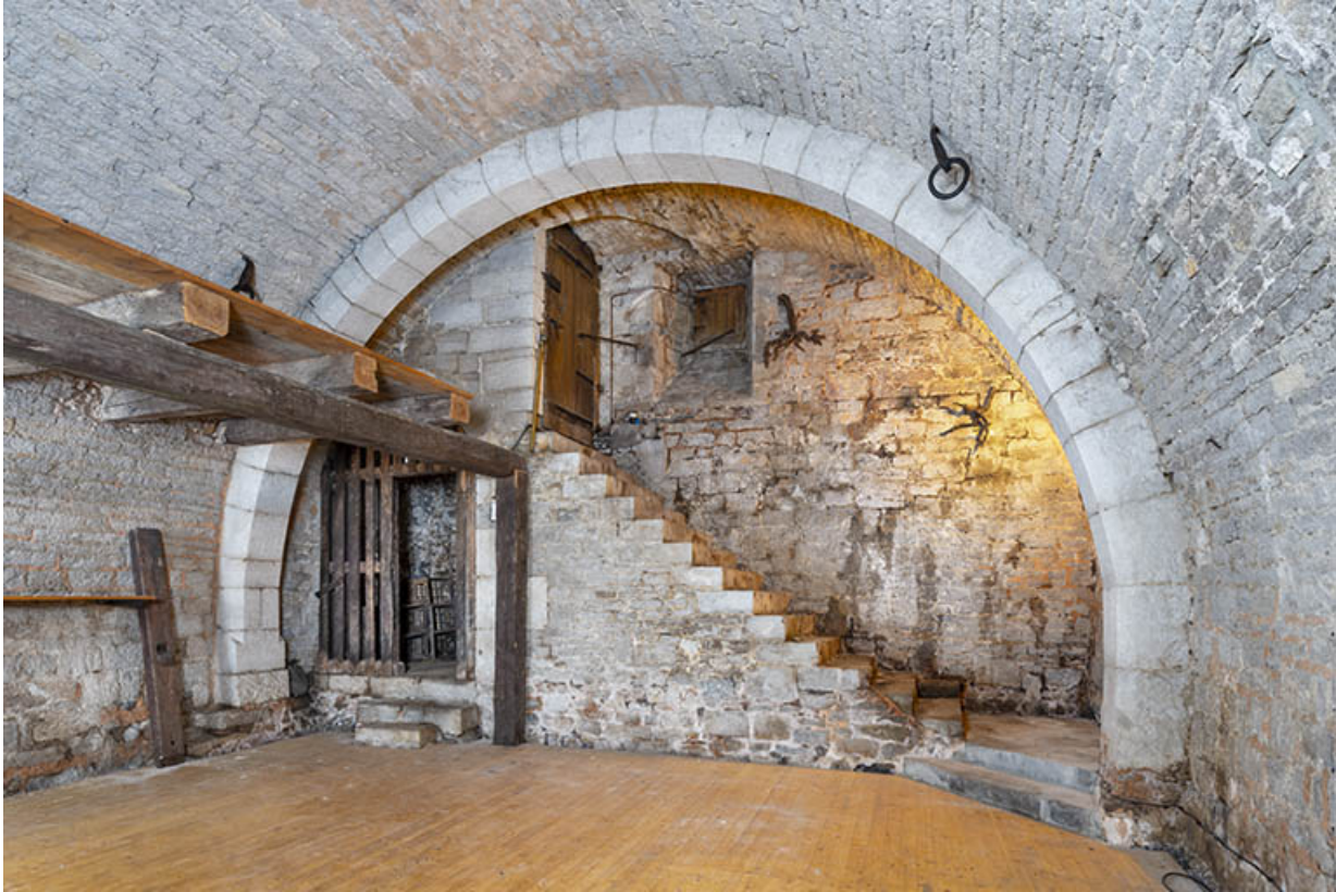
Cave est (aile nord). Extrémité septentrionale. 39, Salins-les-Bains, 13 rue de la Liberté
