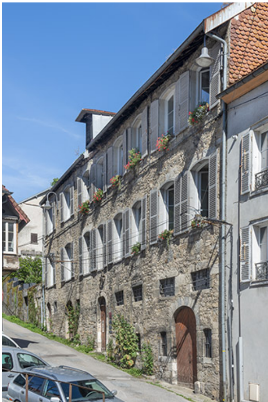
Façade antérieure vue de trois quarts droite.
