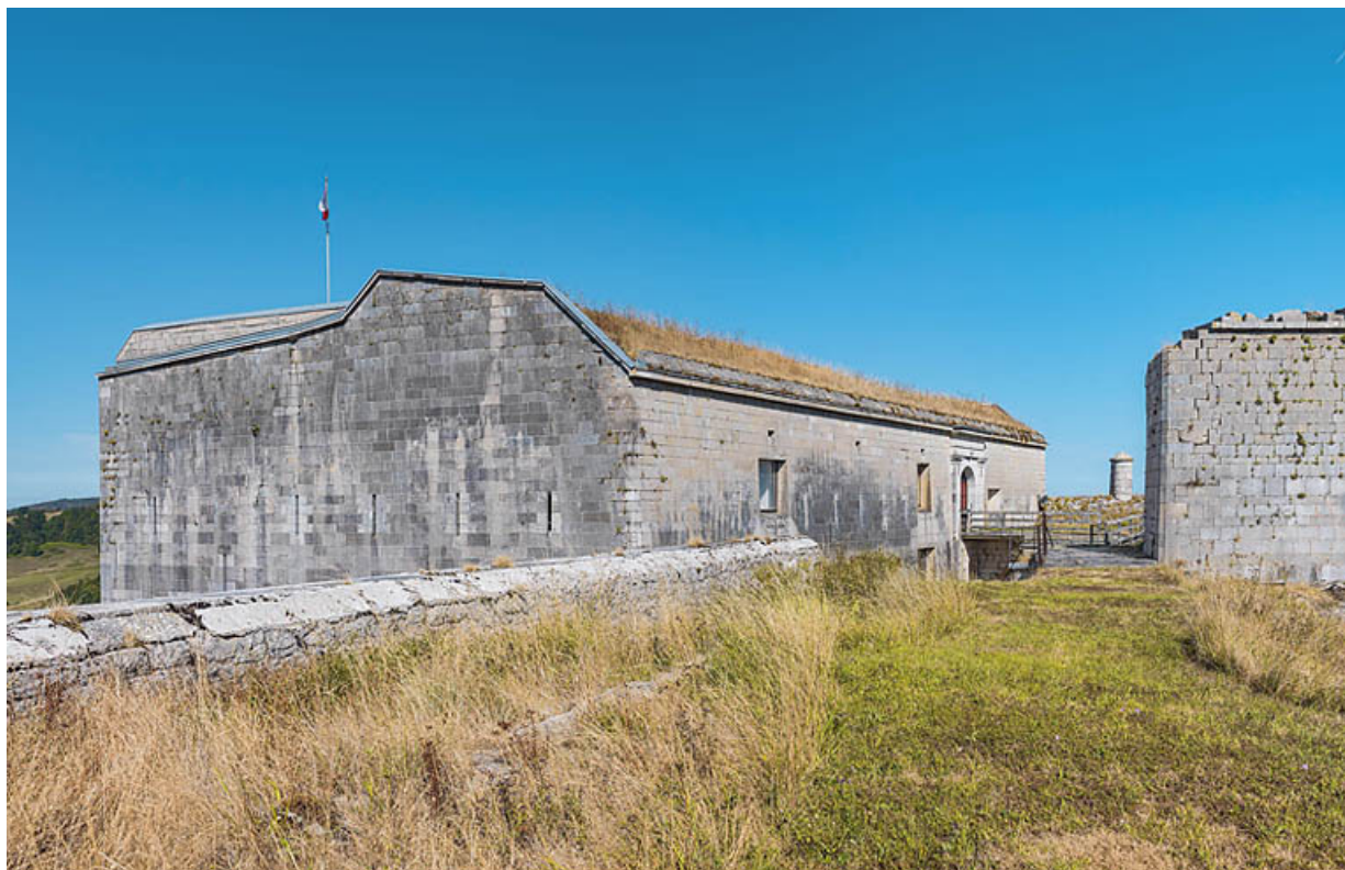
Vue depuis le toit du bâtiment casematé à usage de casernes et magasins.
