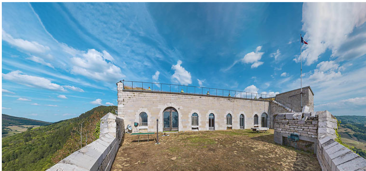
Vue depuis l'échauguette de la façade postérieure.
