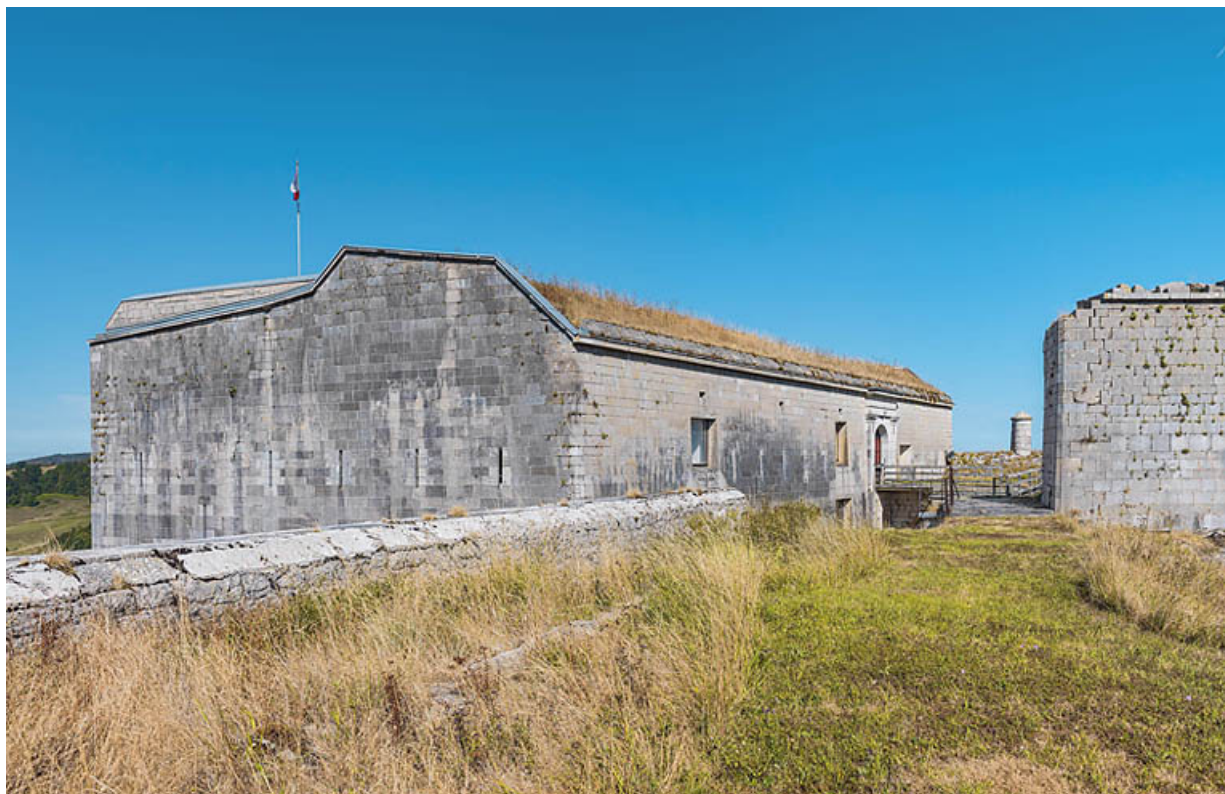
Vue depuis le toit du bâtiment casematé à usage de casernes et magasins.
