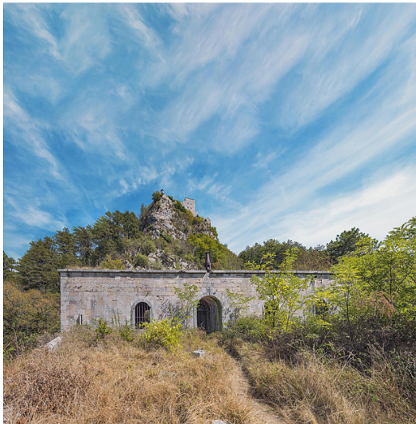
Le bâtiment casematé : la façade antérieure.
