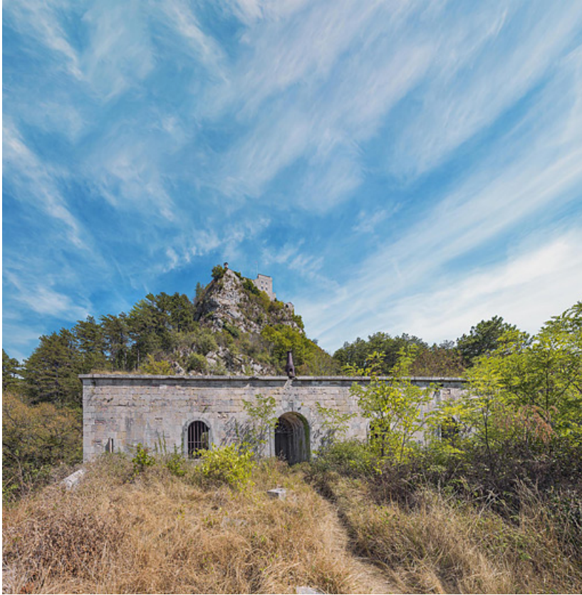
Le bâtiment casematé : la façade antérieure.
