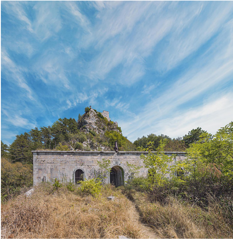
Le bâtiment casematé : la façade antérieure.
