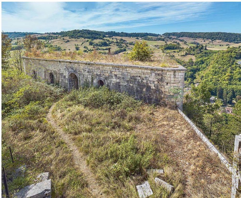
Le bâtiment casematé : façade postérieure.
