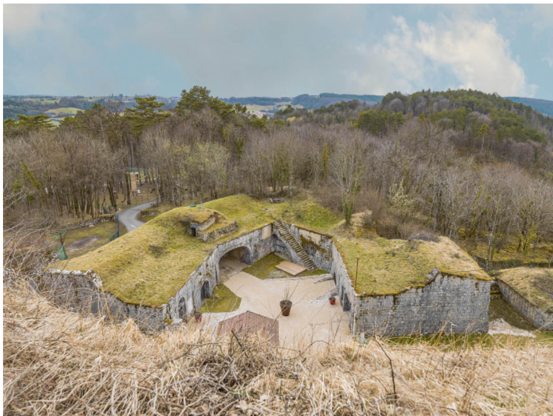
Vue depuis la courtine.
