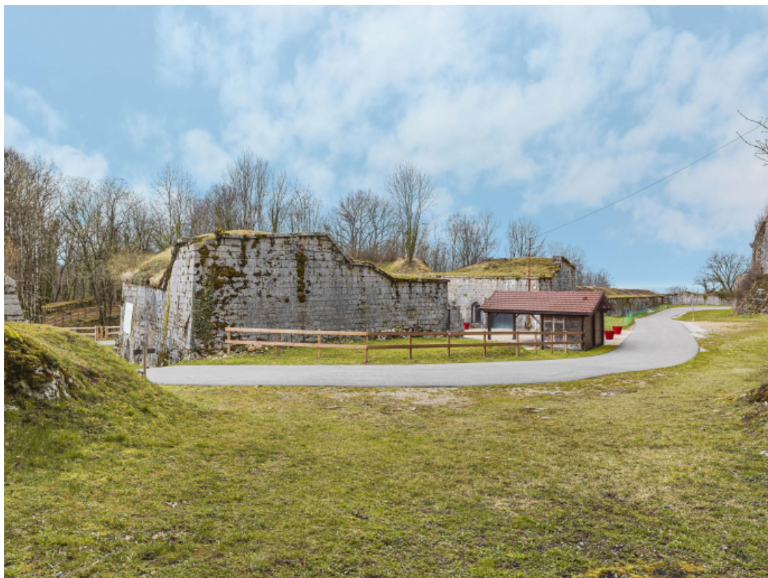
Vue depuis la base du demi-bastion est.
