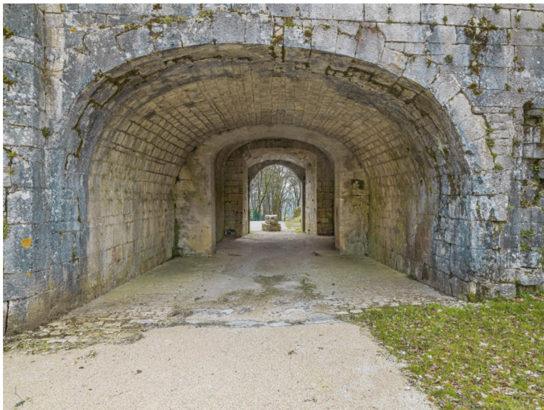
Le passage, vue depuis la cour intérieure.
