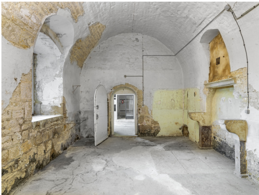
Le passage voûté : vue d'ensemble de la salle du corps de garde.
