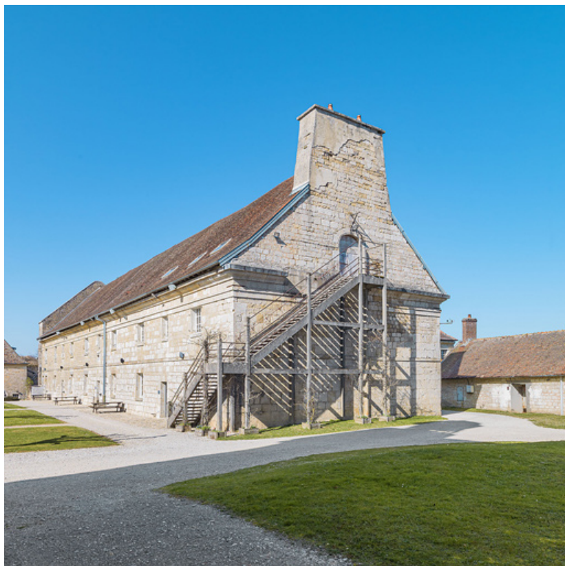
Caserne U : vue de trois quarts droit (façades antérieure et latérale).
