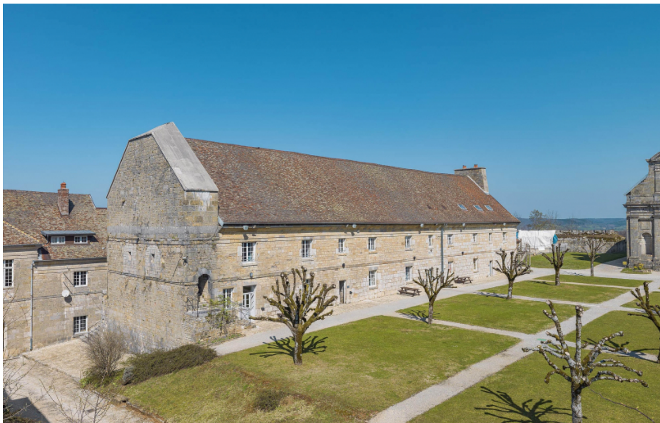
Caserne U : vue de trois quarts gauche (façades antérieure et latérale).
