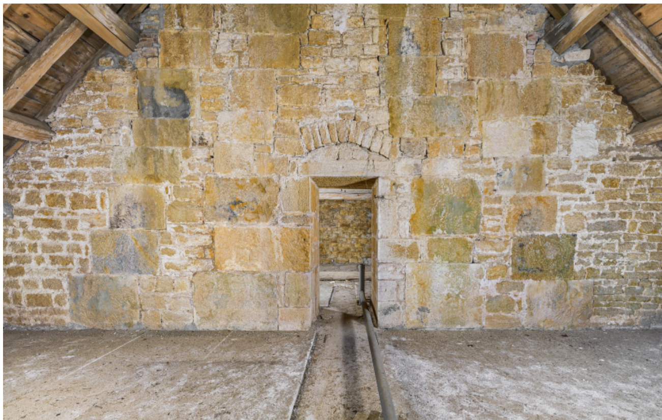
Caserne U, grenier : un des trois murs de refend.
