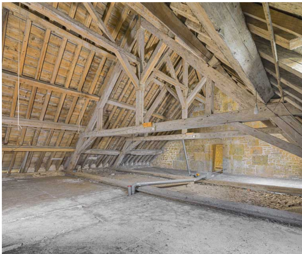
Caserne U, grenier : charpente du bâtiment.
