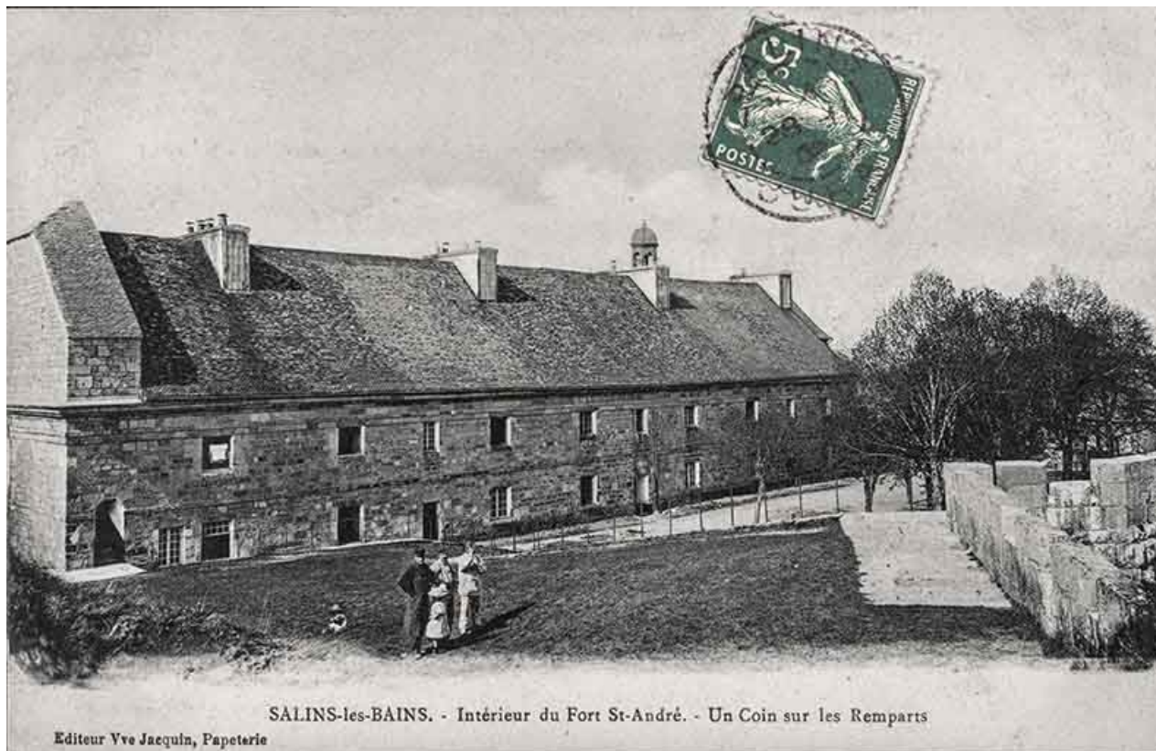
Salins-les-Bains. Intérieur du Fort Saint-André - Un Coin sur les remparts. S.d. 39, Salins-les-Bains chemin communal du Fort Saint-André, lieudit : Fort Saint-André
