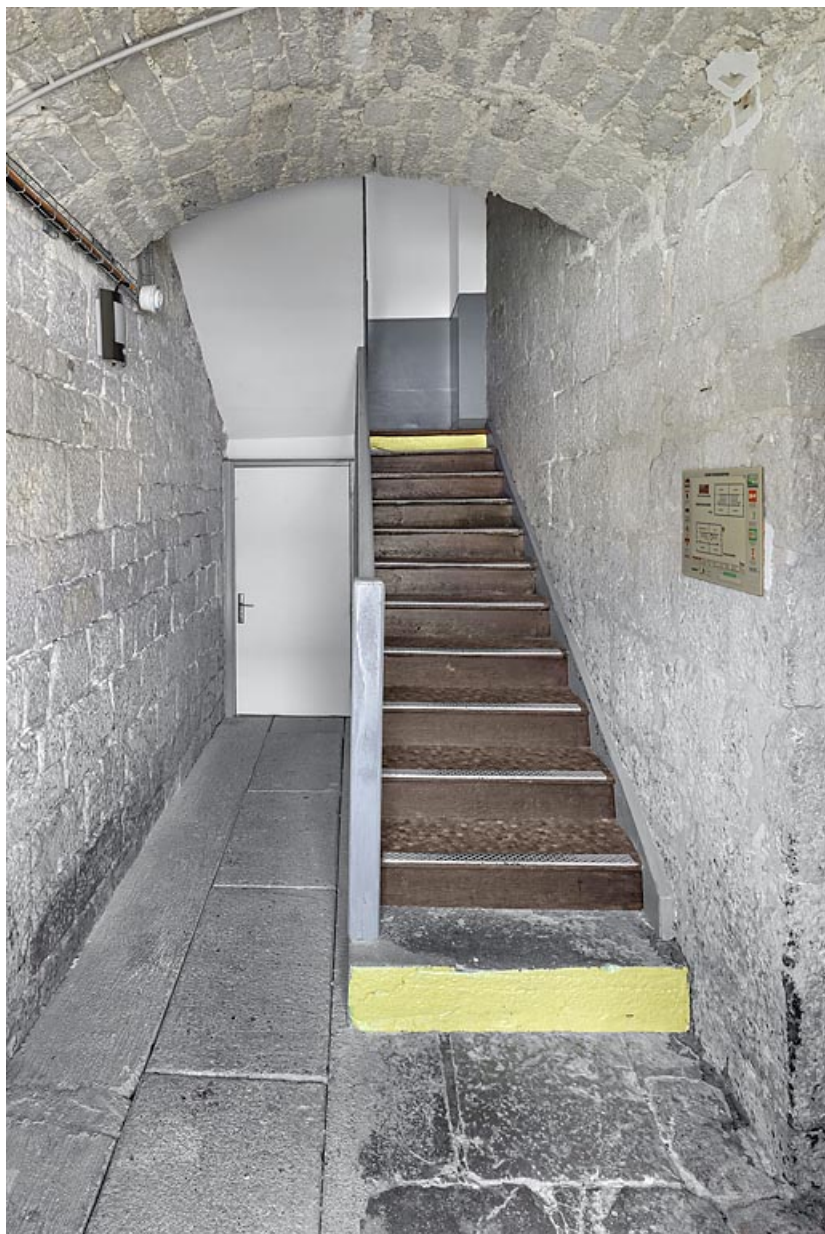
Caserne U, rez-de-chaussée : escalier et la première volée (détail).
