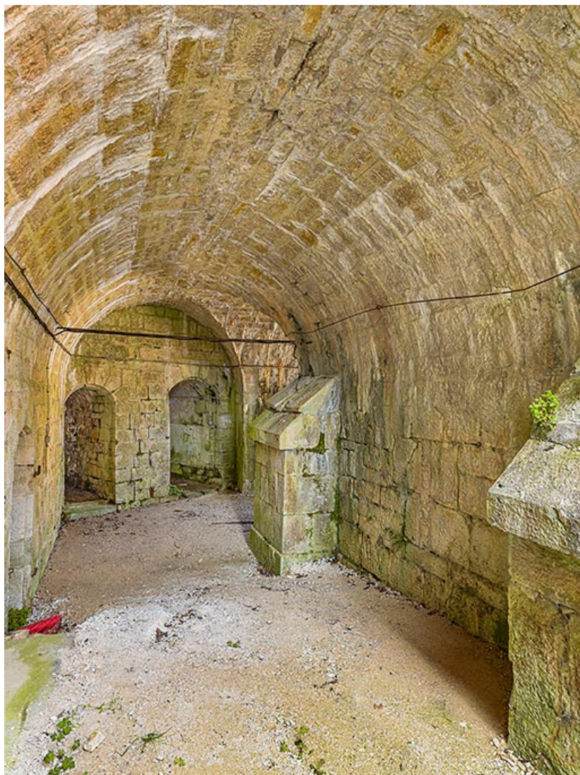
Une partie du couloir entourant l'édifice.
