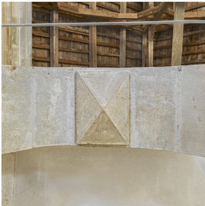
Détail de la clé de voûte de la tribune.
