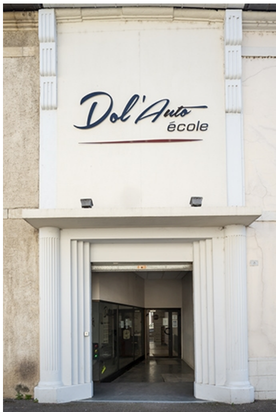
Modern'Cinéma : entrée vue de face. 39, Dole
