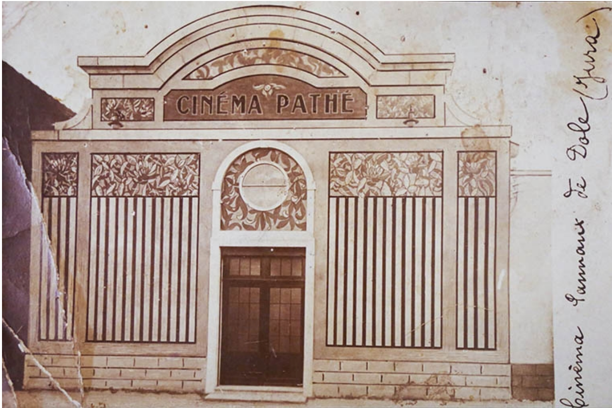
Cinéma Pathé (Pannaux), r. du 21 Janvier : façade (v. 1920). 39, Dole
