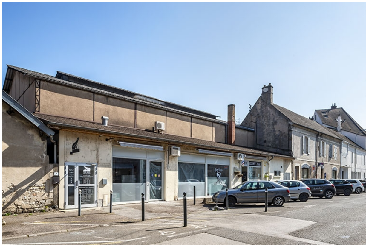
Modern' Cinéma : vue d'ensemble, de trois quarts gauche. Noter le lanterneau sur la salle. 39, Dole
