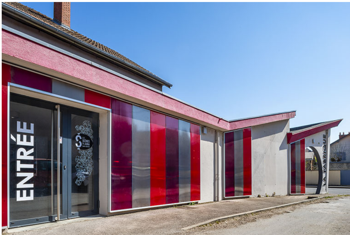
Façade latérale gauche : entrée et vestibule.
