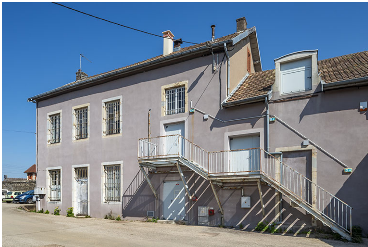
Façade latérale gauche : extrémité avec l'escalier de secours, desservant également la régie. 39, Dole, 30 boulevard du Président Wilson
