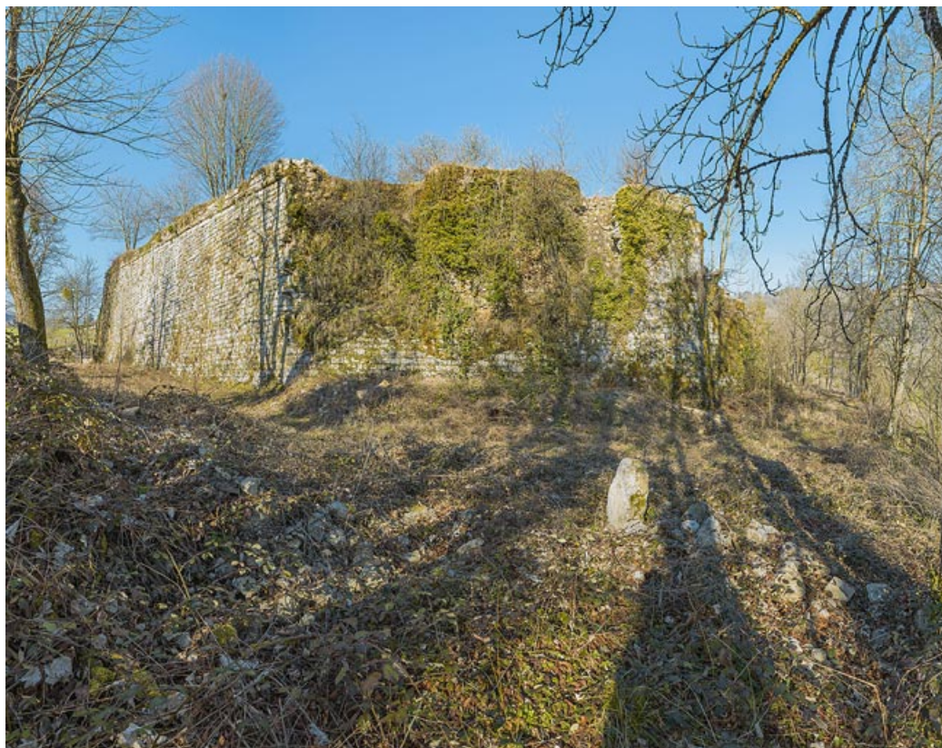
Vue depuis le nord.
