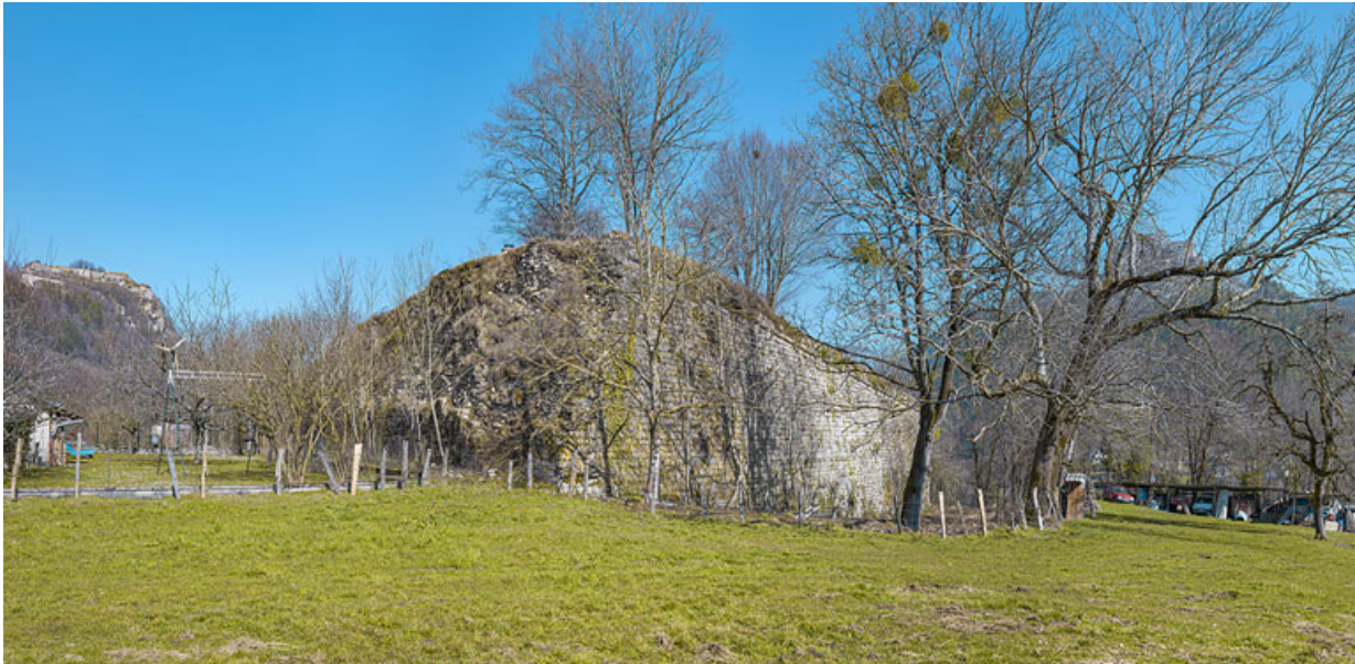
Vue depuis le sud.
