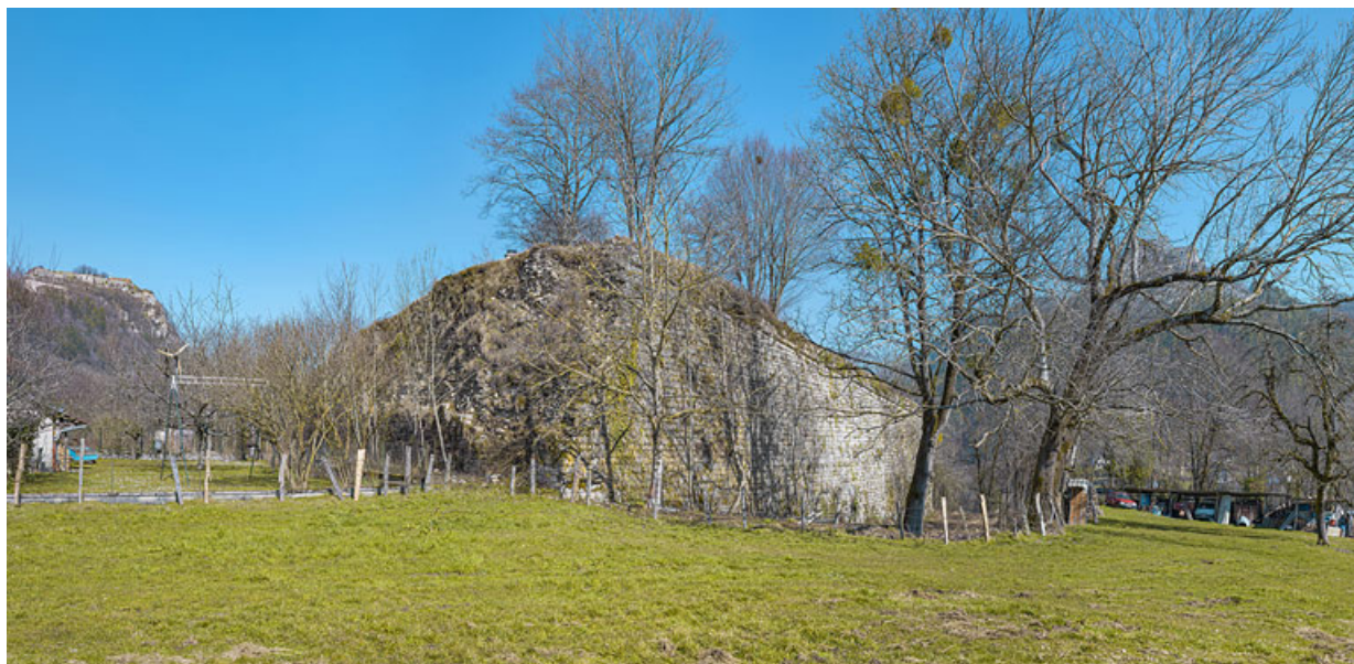
Vue depuis le sud.
