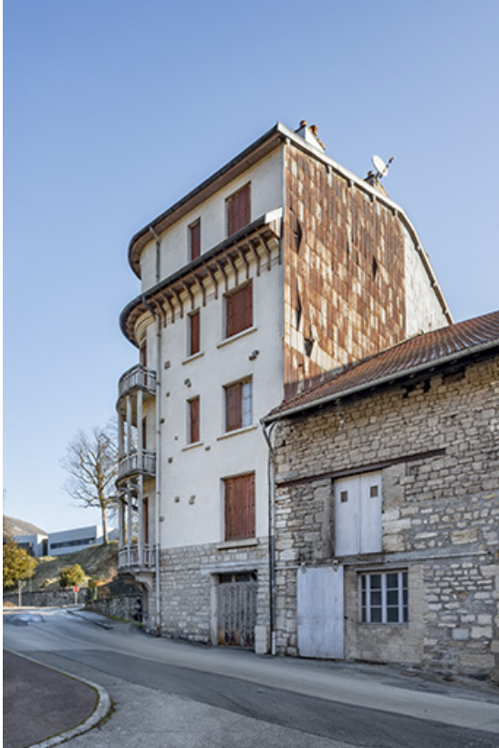
Vue depuis le sud-ouest.
