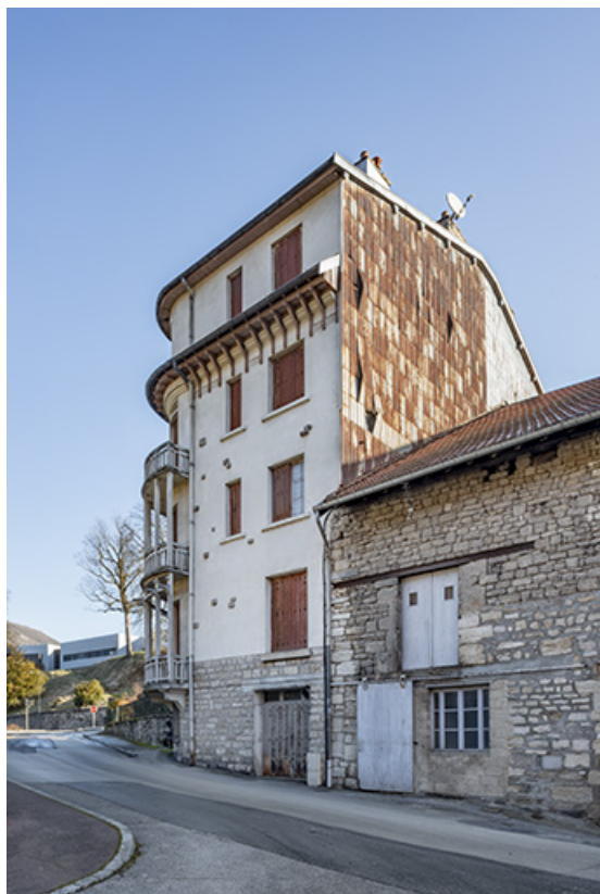
Vue depuis le sud-ouest.
