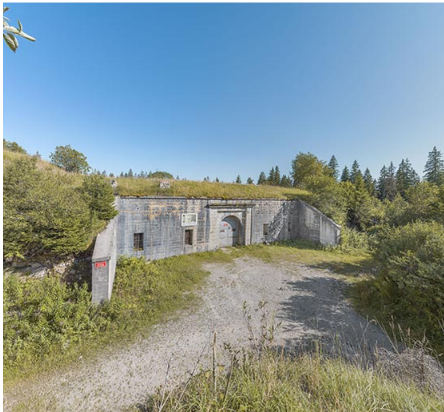
Bâtiment d'entrée, vue de trois quarts gauche.
