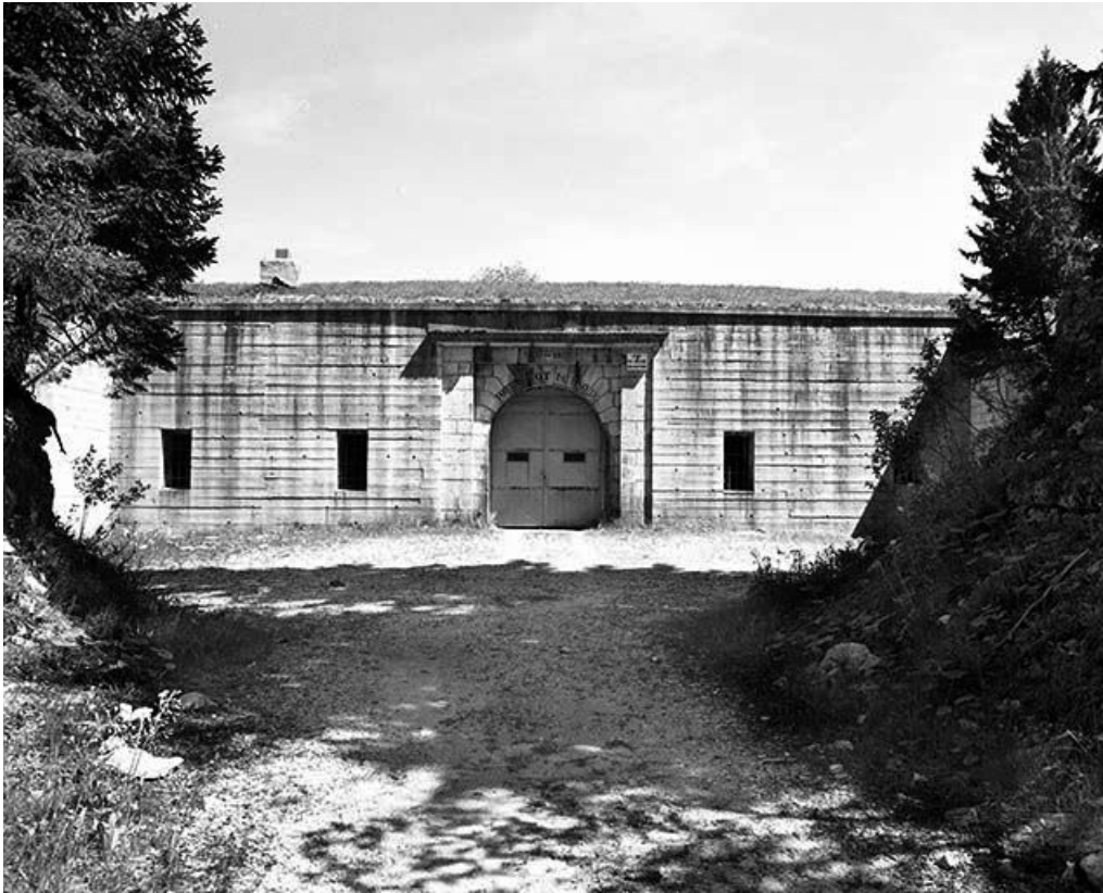
Façade antérieure, vue éloignée.
